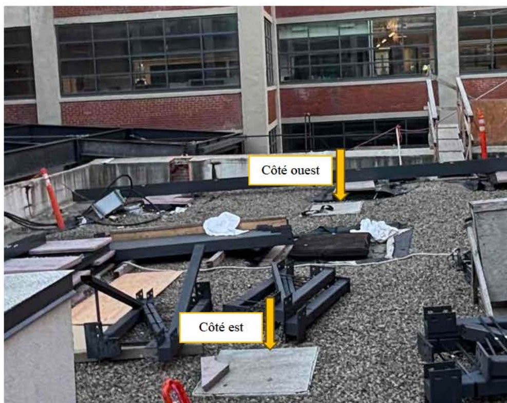
Fig. 8 - Toiture basse avant les travaux de démolition – ouvertures recouvertes d'un morceau de bois et d'une membrane
