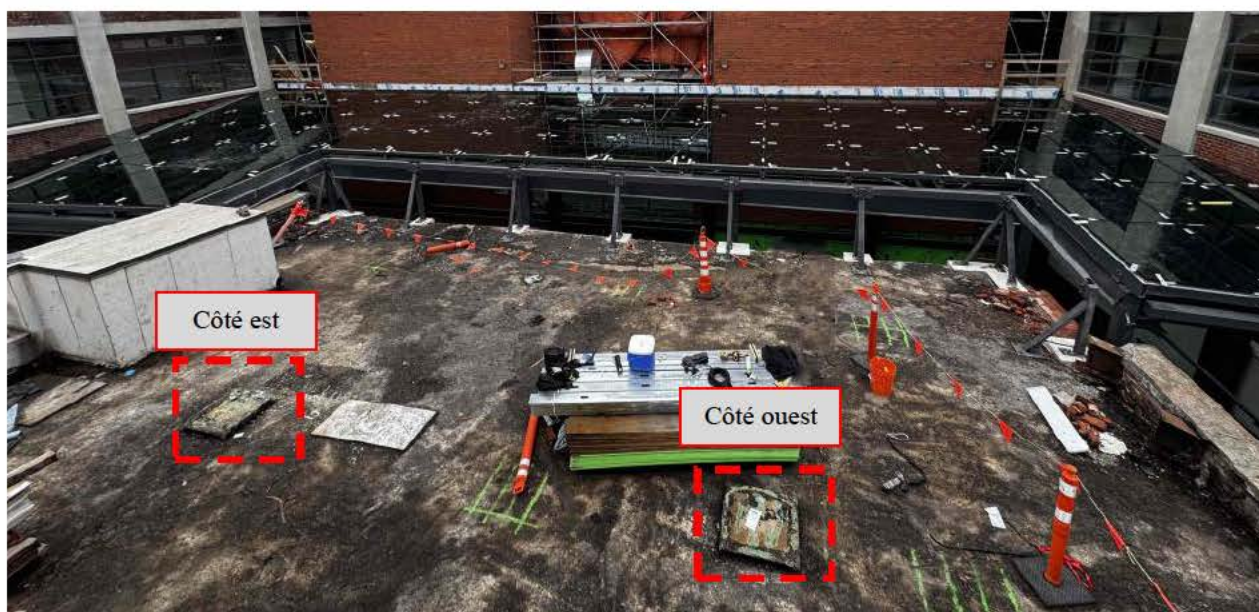
Fig.9 - État de la toiture suivant les travaux de démolition Source : Installation MB, modifiée par CNESST
