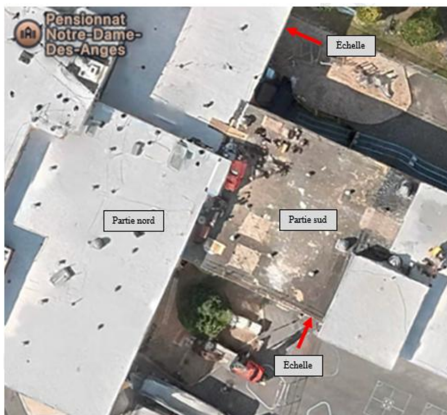
Fig. 2 - Vue aérienne du bâtiment Source : Plan d'Apple (modifiée CNESST)
