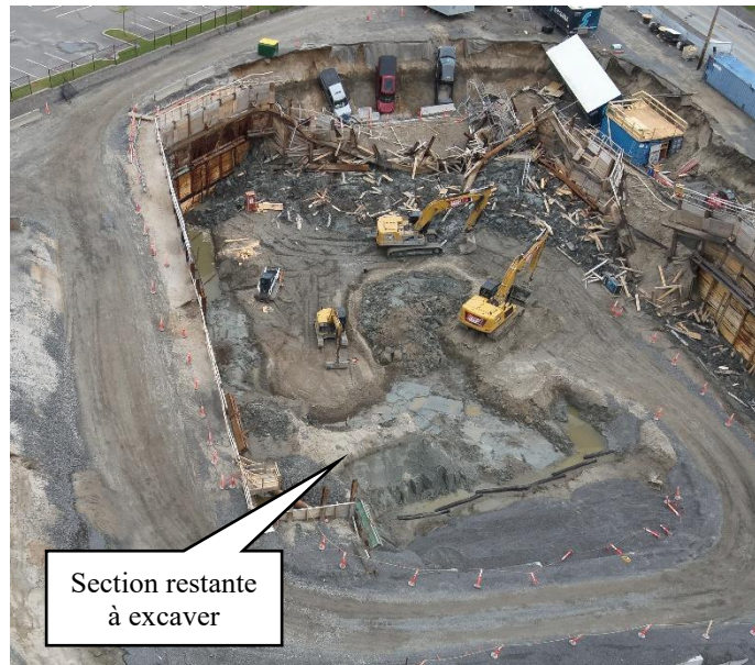
Fig. 4 : Avancement de l'excavation le 20 mai 2025 Source : CNESST
