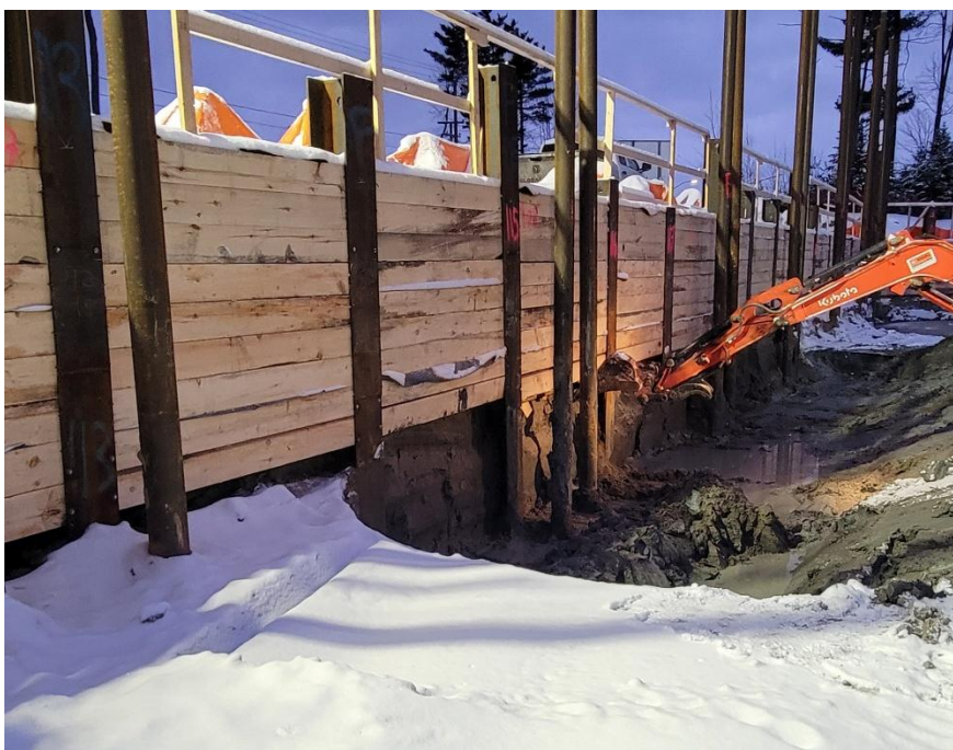
Fig. 8 : Creusage et boisage par section de 1,2 m de profondeur
