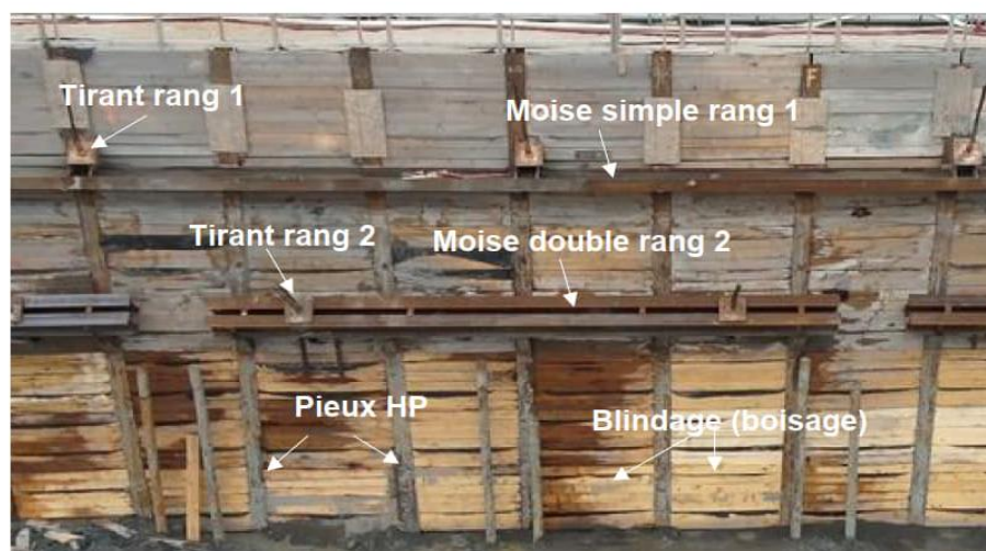
Figure 2 – Composantes du mur berlinois (DC 8)
