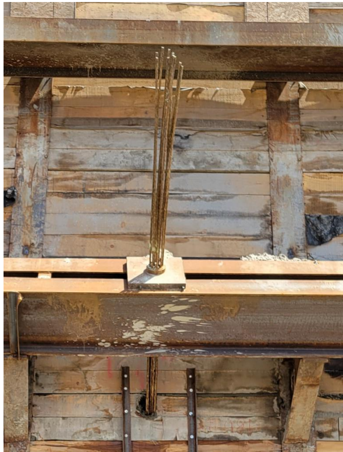
Fig. 12 : Fixation d'un tirant sur une moise Source : Syscomax inc. (rognée par la CNESST)
