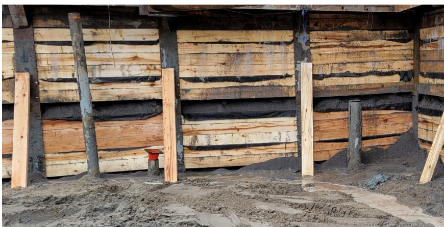
Fig. 9 : Remplissage de l'espace vide derrière le boisage avec un matériau granulaire
