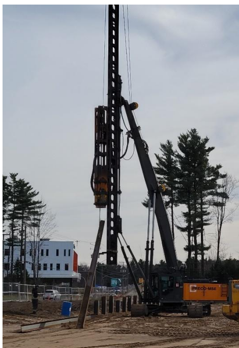
Fig. 6 : Installation de pieux soldats
