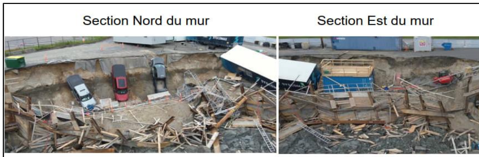
Figure 10 - Vue des surcharges dans le secteur de l'effondrement (source CNESST)
