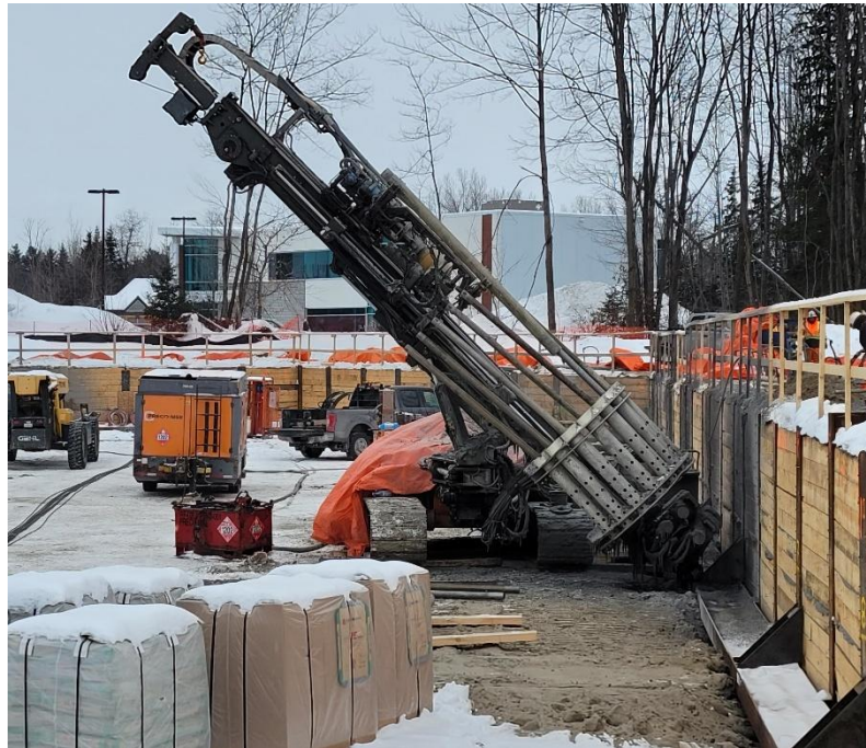
Fig. 11 : Forage pour l'installation de tirants Source : Syscomax inc. (rognée par la CNESST)
