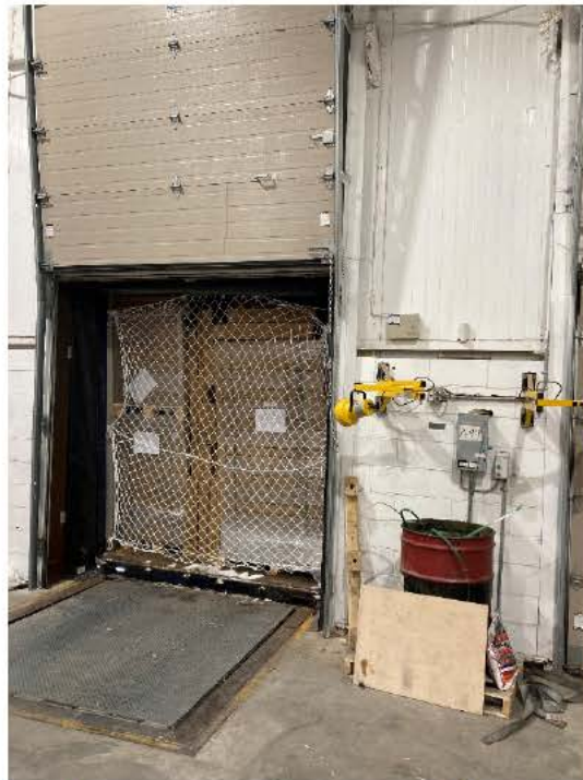
Fig. 4 – Quai numéro 7, vue de l'intérieur Source : CNESST
