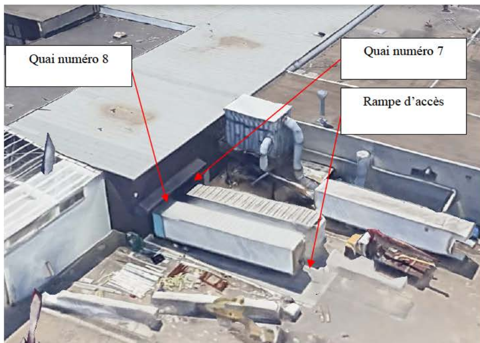
Fig. 5 – Vue aérienne extérieure des quais numéros 7 et 8 de l'établissement de Cuisine Crotone inc.
