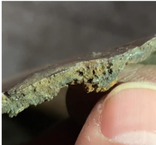
Fig. 7 - Réservoir, rochage d'une soudure de réparation
