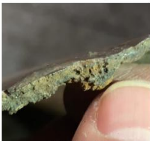
Fig. 7 - Réservoir, rochage d'une soudure de réparation Source : CNESST
