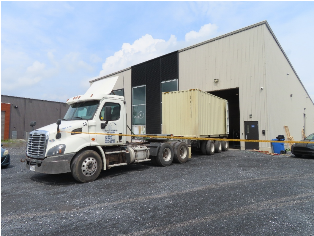
Fig. 2 — Façade du bâtiment
