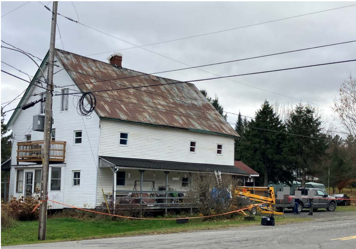
Figure 1 - Photographie du lieu de l'accident
