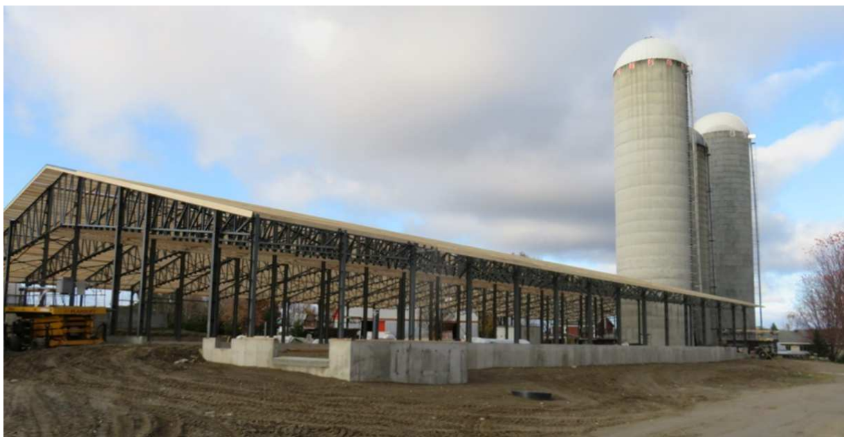
Fig. 2 - Étable laitière robotisée en construction Source : CNESST
