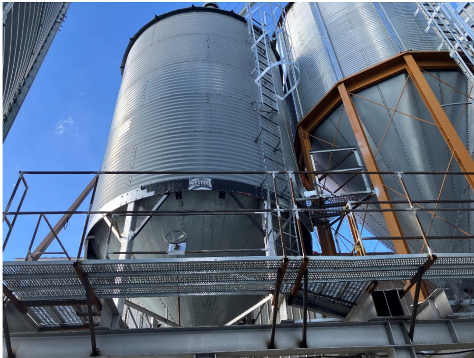
Figure 1 - Lieu de l'accident Source : CNESST
