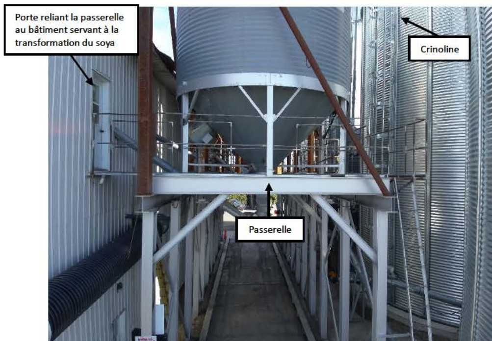
Fig. 3 - Voie d'accès à la passerelle du silo C4 Source : CNESST
