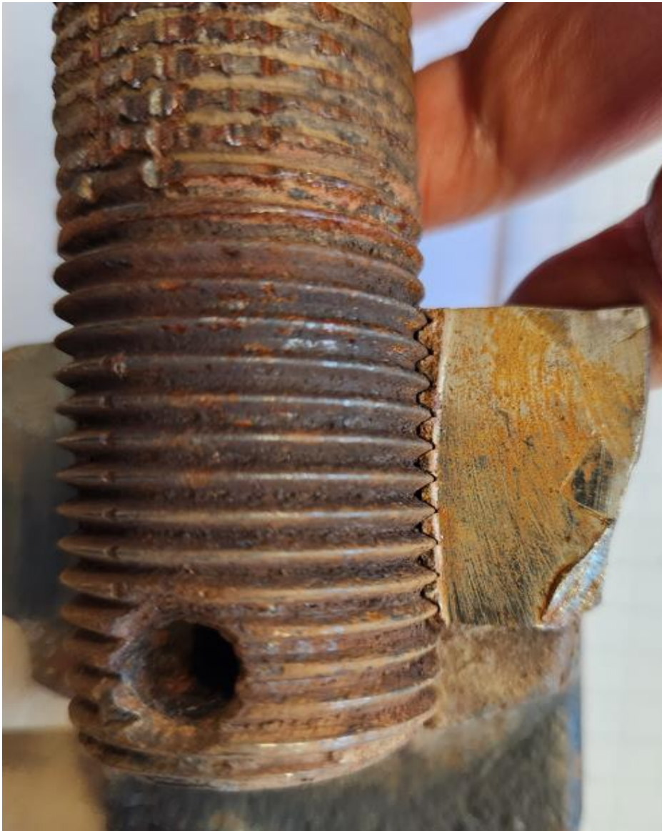
Photographie 1 : Une tige filetée à l'intérieur d'une chape. (Source CNESST).
