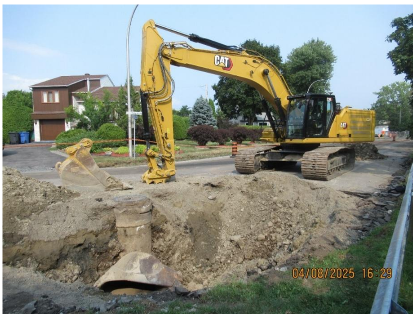
Fig. 22 - Position de la pelle hydraulique avec l'attache rapide au sol Source : CNESST
