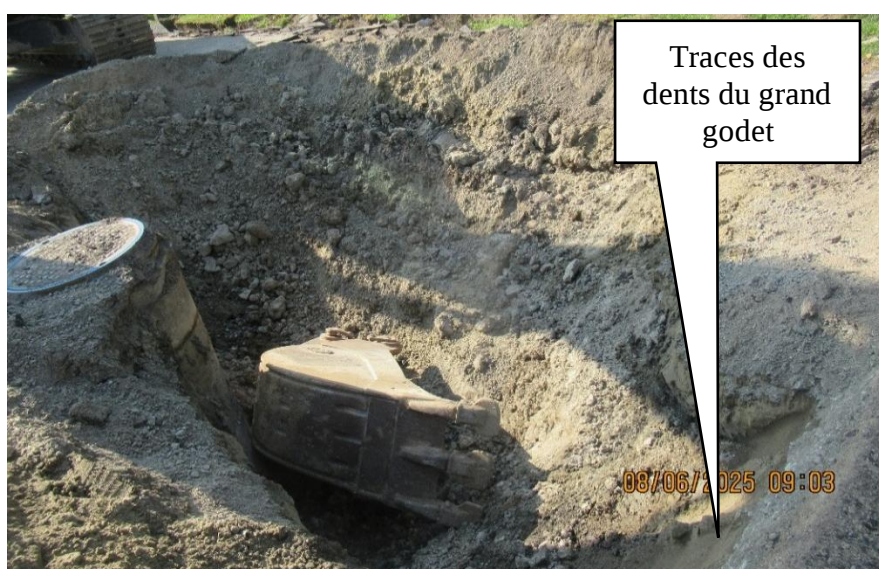
Fig. 20 - Excavation où survient l'accident
