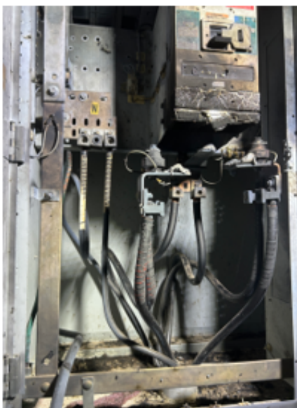
Photo 3 : Disjoncteur au coffret de branchement, alimenté par le bas, en position OFF
