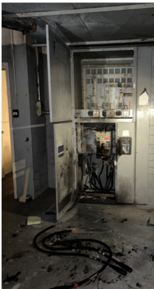
Photo1 : Intérieur du coffret de branchement (section du bas) à la suite de la déflagration
