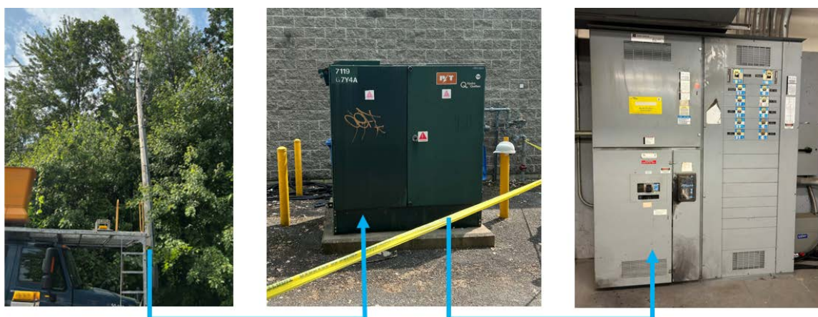
Fig. 5 – Chemin électrique à partir du réseau d'Hydro-Québec Source : CNESST
