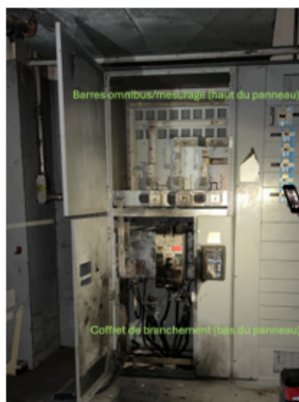
Coffret de branchement HQ (Bas), Mesurage et barres omnibus (haut)
