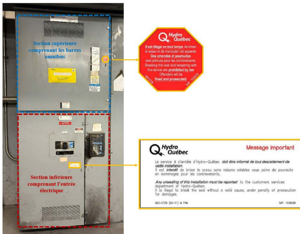
Fig. 6 – Coffret de branchement Source : CNESST
