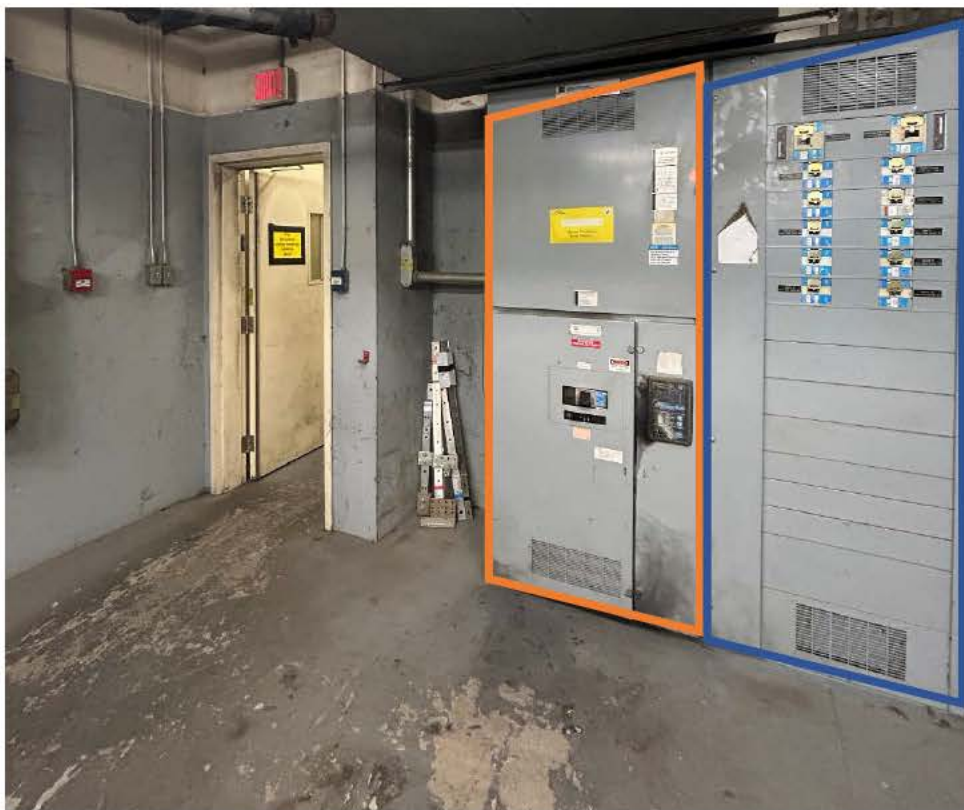
Fig. 3 – Coffret de branchement (orange) et panneau de distribution (bleu)
