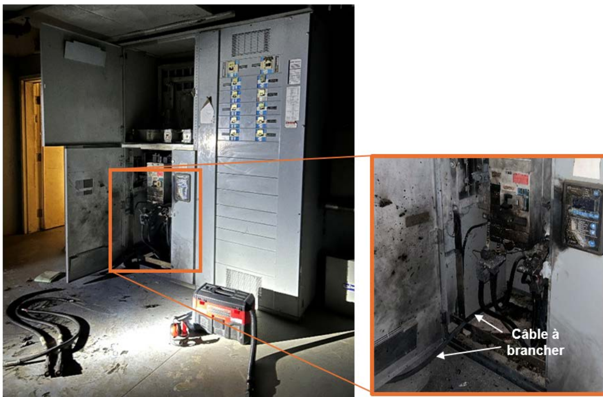
Fig. 10 – État du coffret de branchement à la suite de l'événement Source : CNESST
