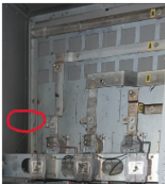
Photo 4 : Cousse de neutre manquante du côté mesurage
