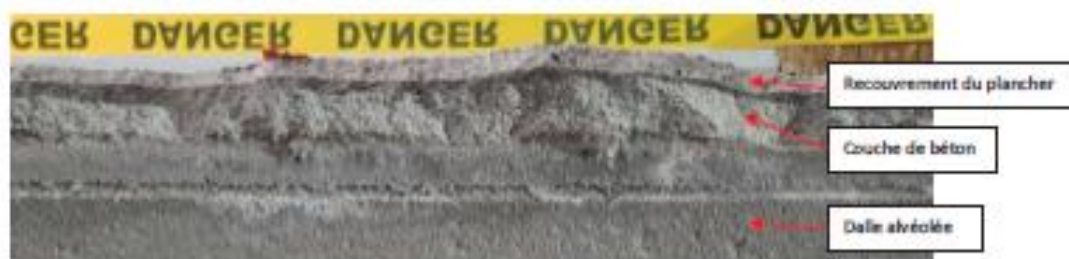
Photo 1 : Recouvrement du plancher et couche de compression en béton sur une dalle alvéolée (Source : CNESST)
