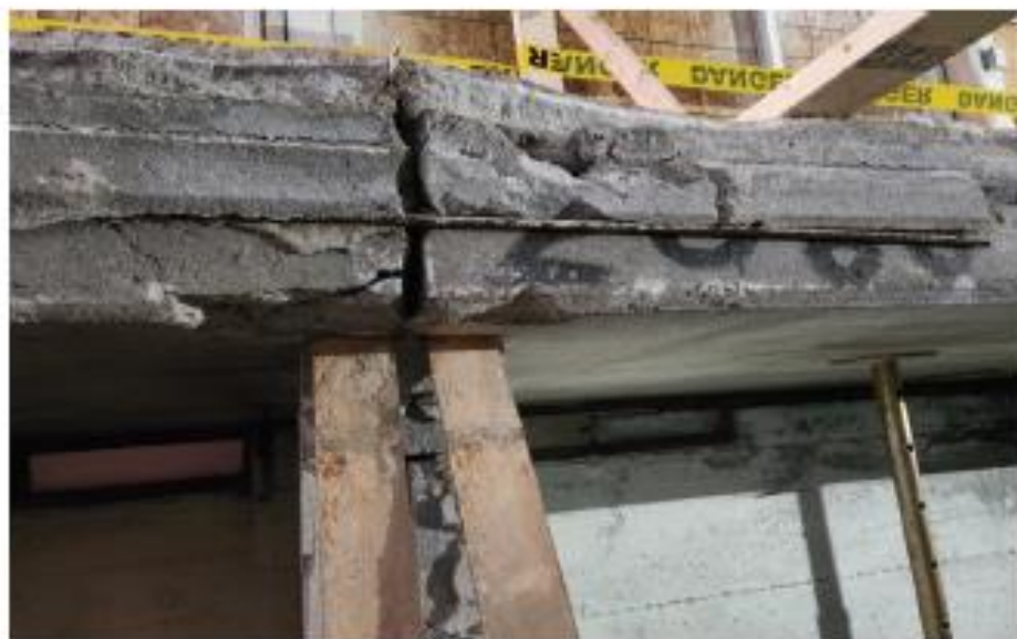
Photo 3 : Barre de 10M dans un joint sur un mur porteur (Source : CNESST)
