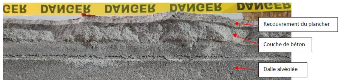
Fig. 8 – Recouvrement du plancher et couche de compression en béton
