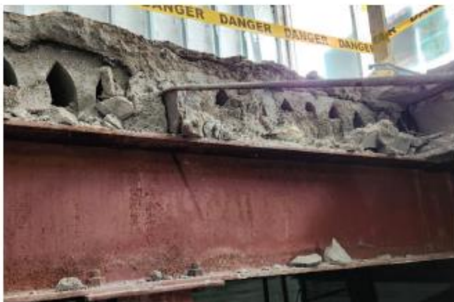
Photo 4 : Barre de 10M dans un joint sur une poutre d'acier (Source : CNESST)
