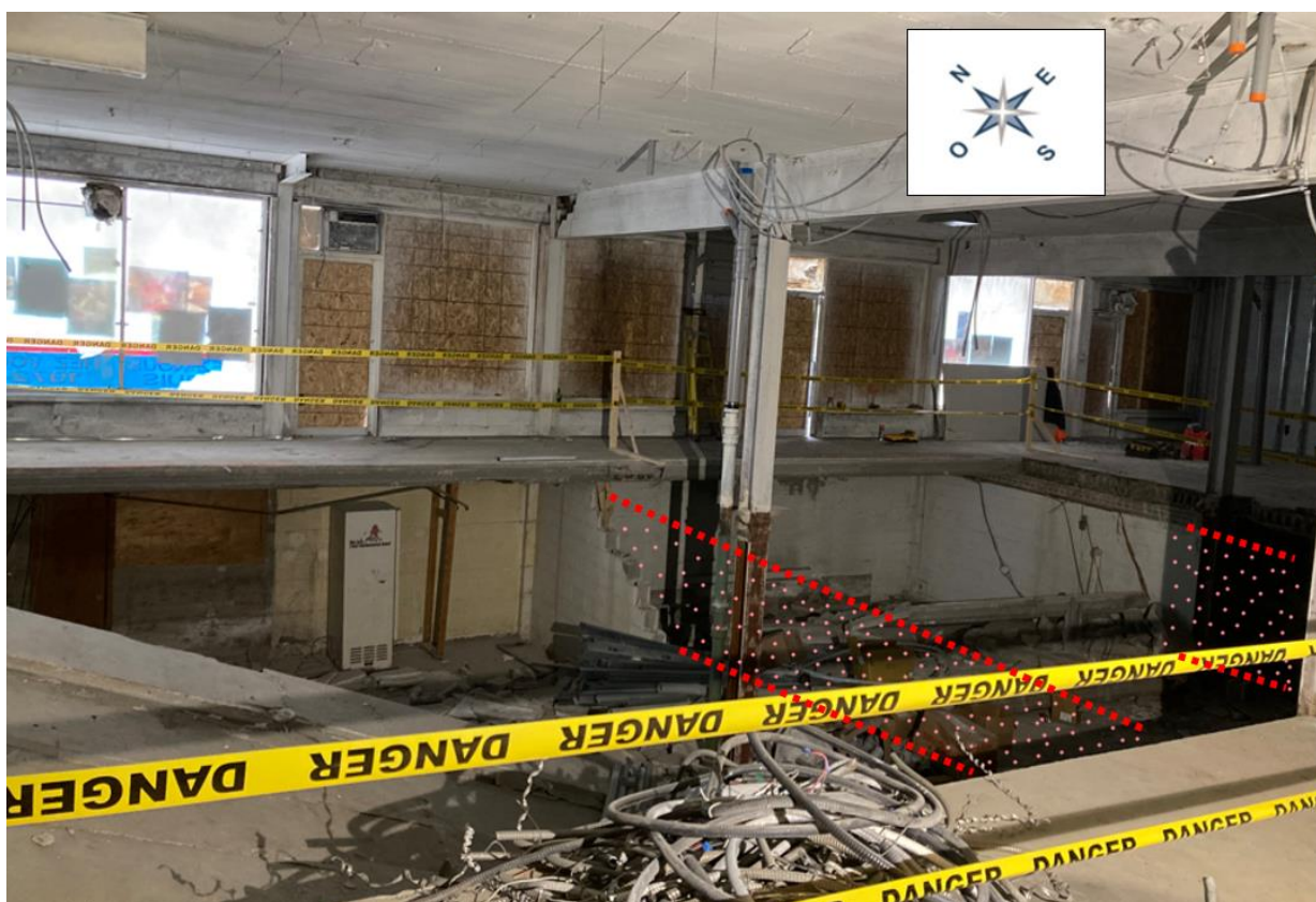
Fig. 11 – État des murs porteurs démolis suivant l'effondrement
