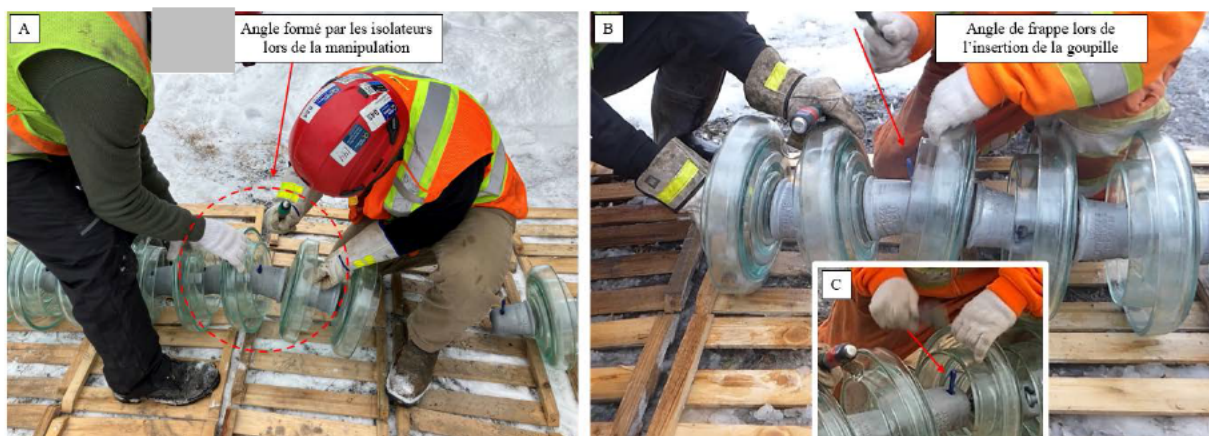
Fig. 30 – Angle induit au moment de l'insertion de la goupille Source : CNESST
