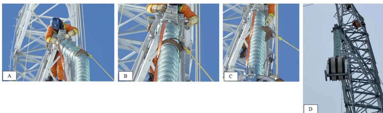
Fig. 12 – Boulonnage de l'ensemble à la 1 ère console d'un pylône du même type que le n° 121
