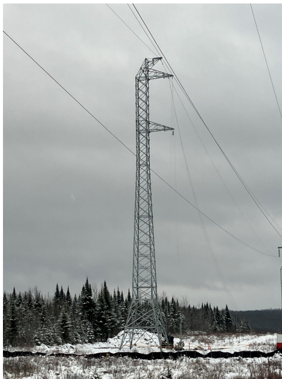
Figure 1 – Pylône n° 121 Secteur nord du chantier QPL2W Appalaches-Maine – Sainte-Praxède Source : CNESST
