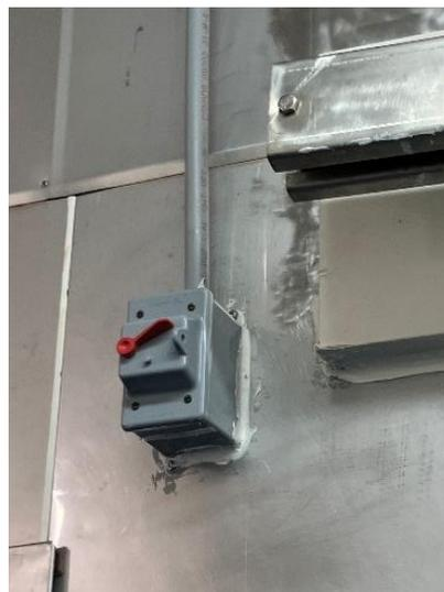
Fig. 9 – *Exemple de boîtier d'interrupteur Kraloy VSC15/10*
