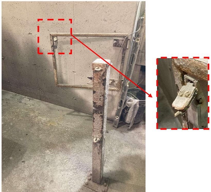
Fig. 22 - Barrière et interrupteur à clé
