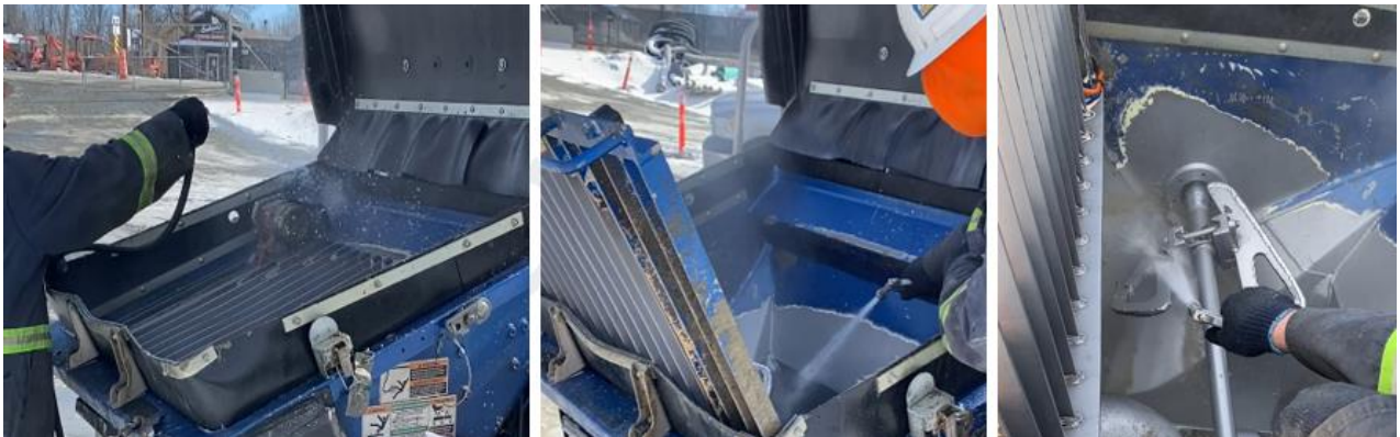
Fig. 4 : Photos montrant le nettoyage d'une trémie de pompe à béton (grille abaissée et relevée) Source : CNESST
