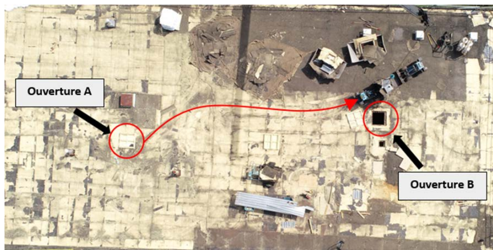
Figure 5: Trajet effectué pour le transport de la boîte de ventilation condamnée de l'ouverture du toit A vers la zone de levage.
