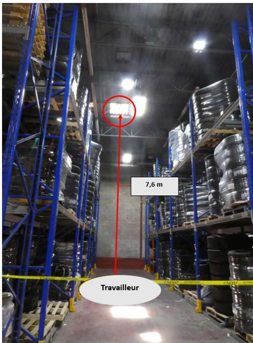
Figure 9 : Vue de l'intérieur du bâtiment Source : CNESST, photo P1090802 modifiée
