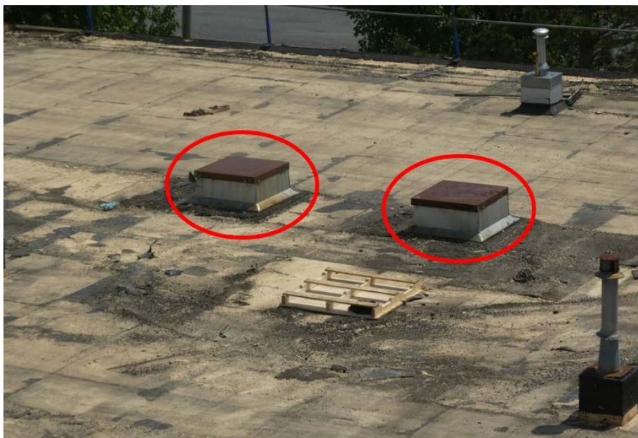
Figure 4 : Exemples de boîtes de ventilation condamnées
