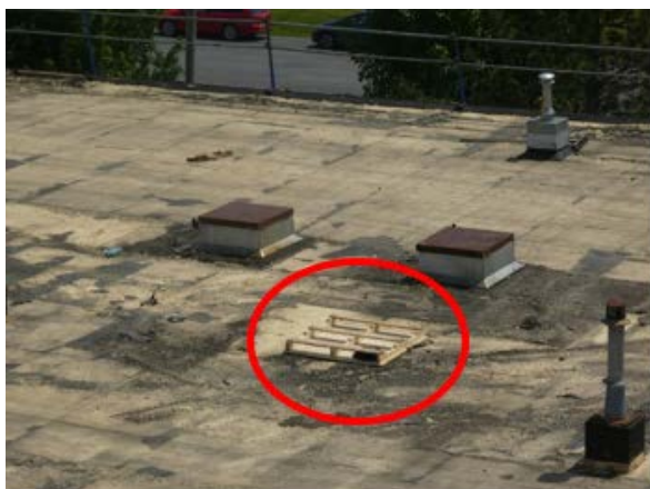
Figure 13 : Palette de bois utilisée pour le recouvrement temporaire de l'ouverture du toit A
