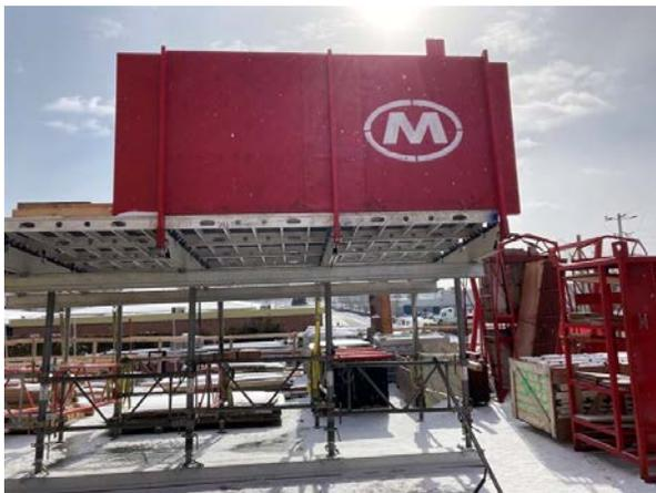
**Fig. 5** - *Vue de face d'une forme volante*
