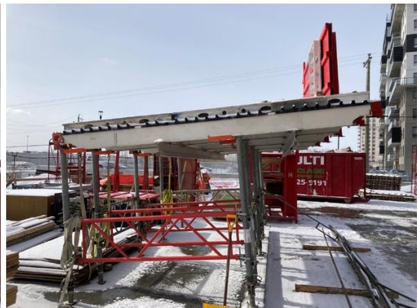
**Fig. 6** - *Vue de côté d'une forme volante*
