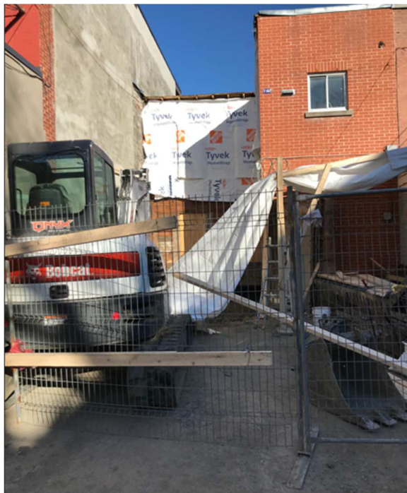
Fig. 3 - Accès au chantier par la ruelle
