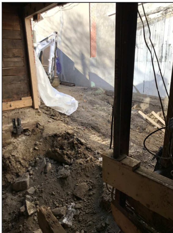
Fig. 4 - Excavation à l'intérieur du bâtiment
