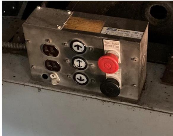
Fig. 7 – Dispositif de commande pour l'inspection de l'ascenseur 5
