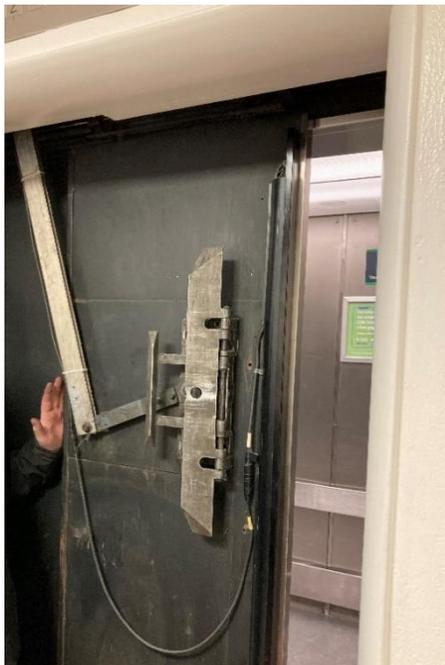
Fig. 12 – Dispositif d'embrayage de la cabine vue du palier
