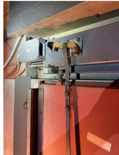
Fig. 11 – Mécanisme d'ouverture
