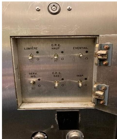
Fig. 6 – Intérieur du panneau verrouillé de l'ascenseur 6
