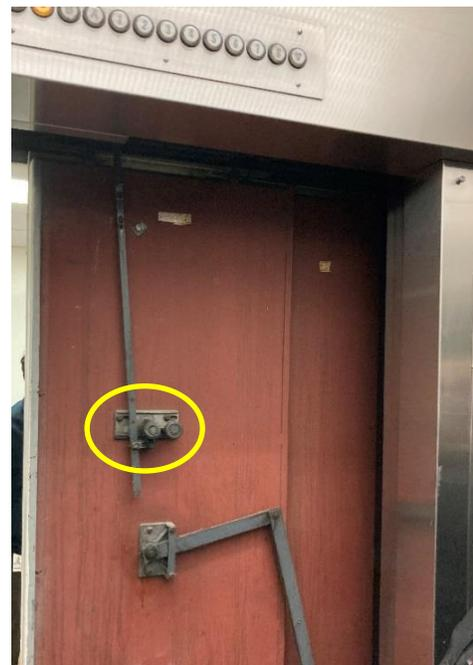
Fig. 13 – Intérieur de la porte palière porte vue de la cabine
