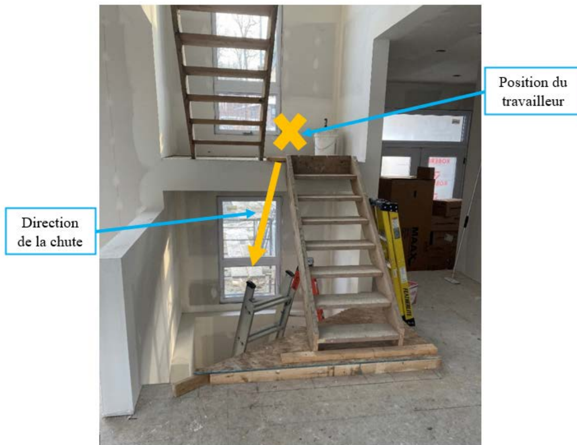
Figure 1 - Photographie du lieu de l'accident
