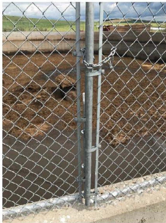
Photo 3 : Chaîne munie d'un crochet en « S » à la barrière de la rampe n° 2 (Source : CNESST)
