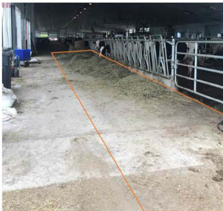
Photo 7 : Zone nettoyée le 8 août 2022 en avant-midi (Source : CNESST)
