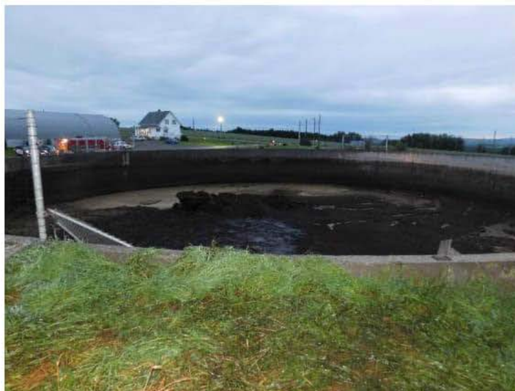
Photo 5 : Haut de la rampe d'accès n°1 après l'accident (Source : CNESST)
