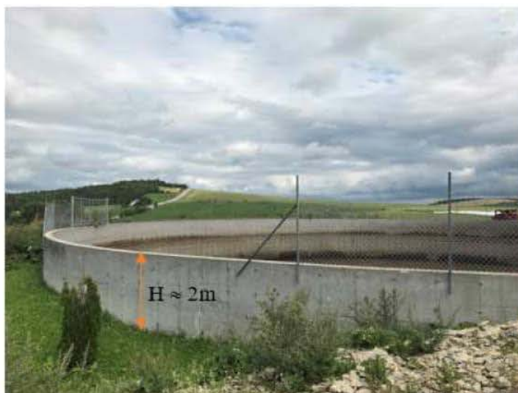
Photo 2 : Vue générale de la fosse à fumier (diamètre = 38 m, hauteur totale = 4 m, épaisseur = 25 cm) (Source : CNESST)
