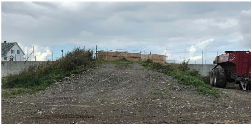
Photo 4 : Vue de face de la rampe d'accès n° 1 (Source : CNESST)
