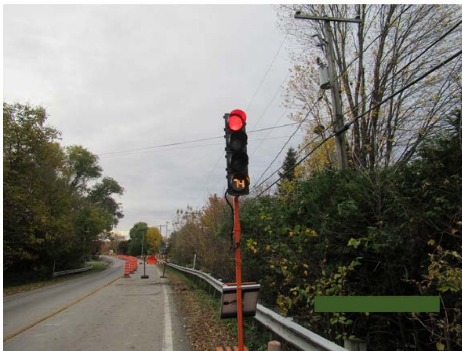
Fig. 6 : Feux de circulation pour travaux sur la voie en direction sud
