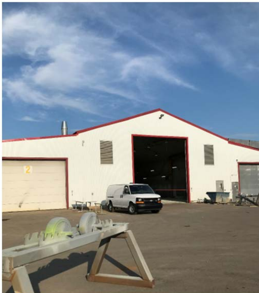
Fig. 3 – Portes 2,3 et 4 du bâtiment central
