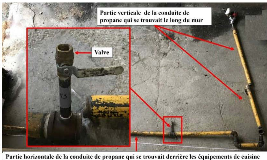
Fig. 16 -Sortie non obturée.
