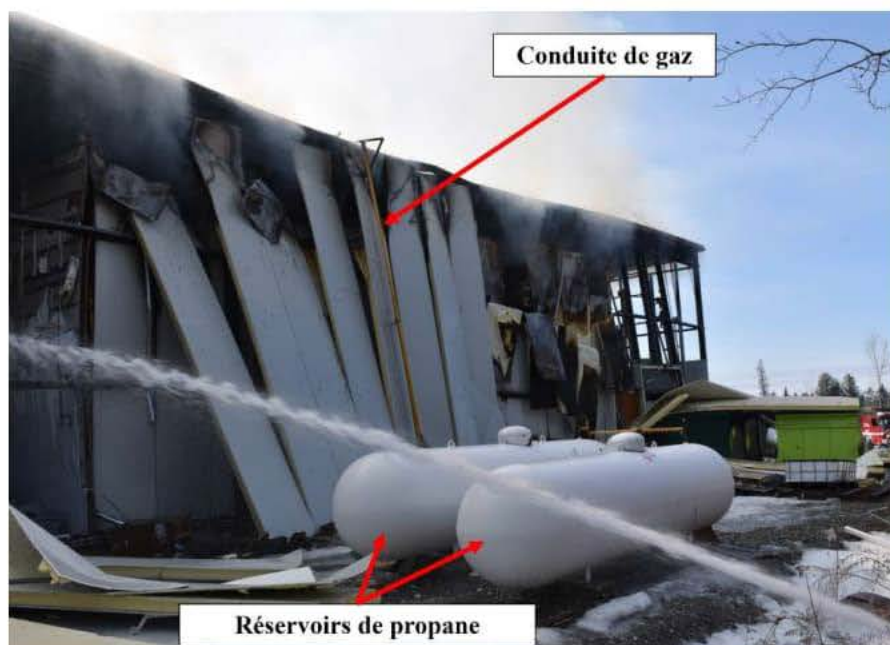
Fig. 7 -Photographie des dommages arrière du bâtiment Source : Service de protection contre les incendies
