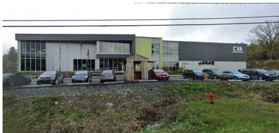
Fig. 2 -Photographie du bâtiment avant l'événement
