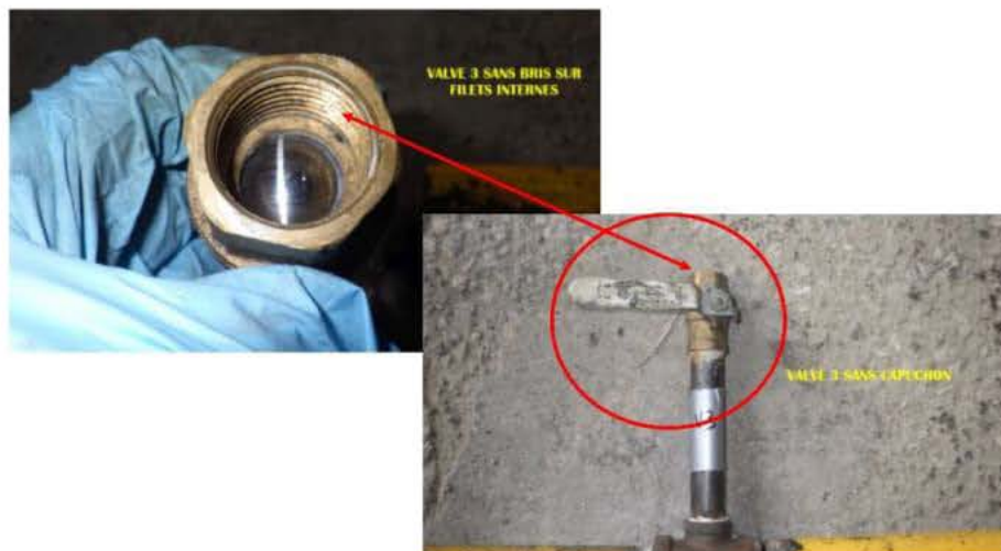
Fig. 18 -Sortie non obturée. Source : Richard C. Gaillardetz
