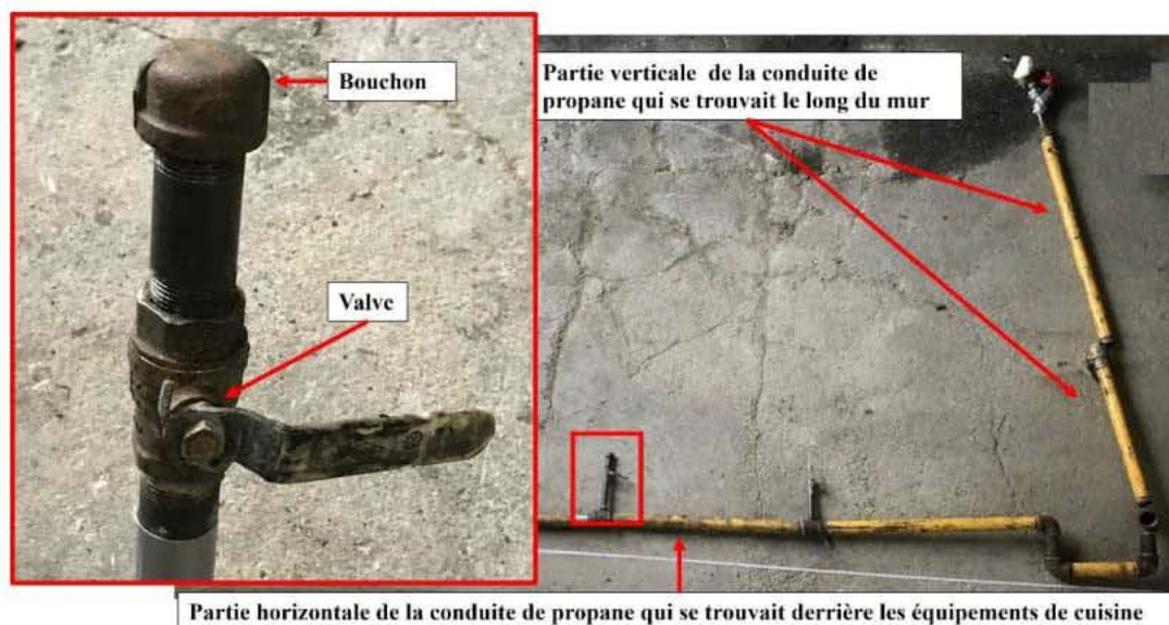
Fig. 14 -Sortie obturée à l'aide d'une valve et d'un bouchon compatible à la tuyauterie.
