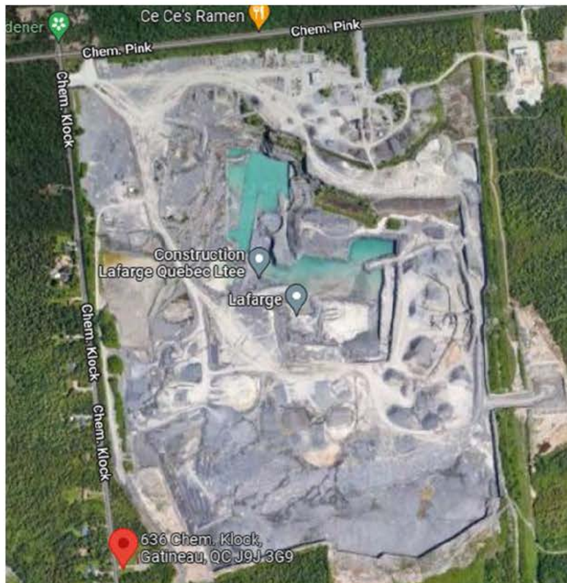
Fig. 3 - Vue aérienne de la carrière
