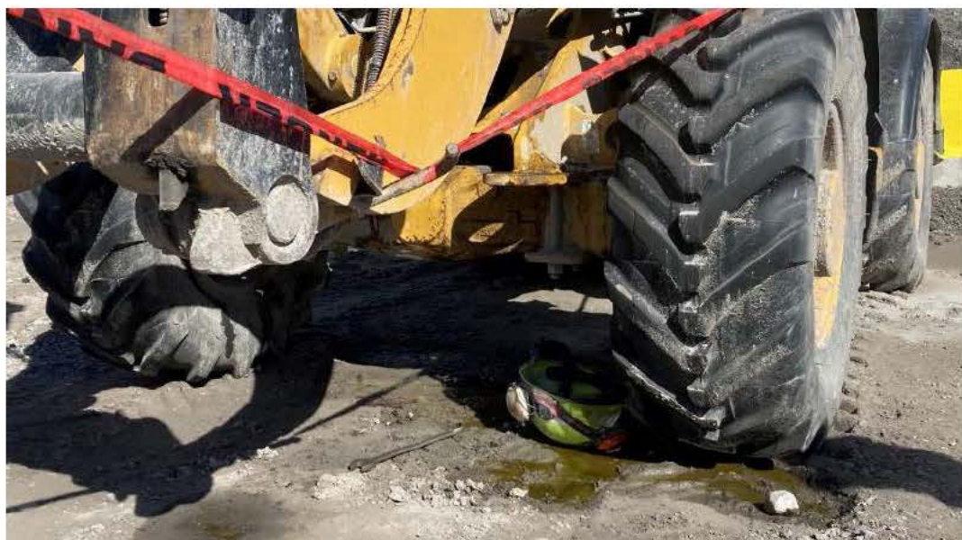
Fig. 9 - Photographie de l'huile hydraulique, du casque de sécurité et de la clé d'un pouce Source : CNESST
