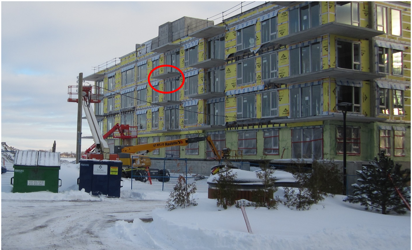
Figure 1 - Photographie du lieu de l'accident (encerclé sur la photo)
