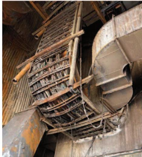
Photo 10 – Caniveau de câbles électriques
