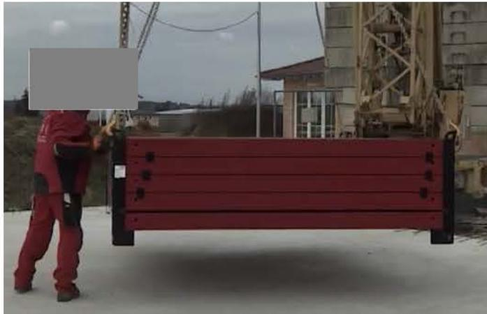
Figure 14 : Exemple d'un transport de panneaux de coffrage en pile à l'aide des angles de levage à leur arrivée au chantier
