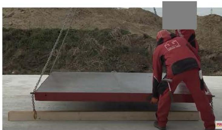
Figure 15 : Exemple d'un transport horizontal d'un panneau de coffrage à l'aide des élingues MX (Source : Peri Group, Youtube : [TRAINING | PERI MAXIMO safely transport with stacking pallets \(EN\) - YouTube](#))
