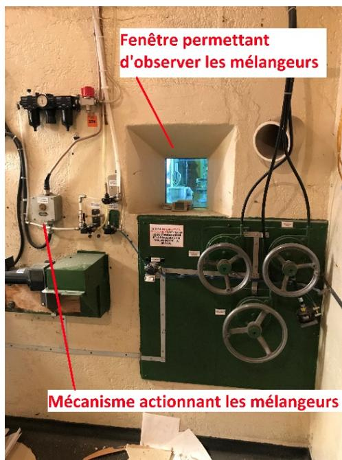
*Photo 3 : Fenêtre d'observation et mécanisme actionnant à distance les mélangeurs*
