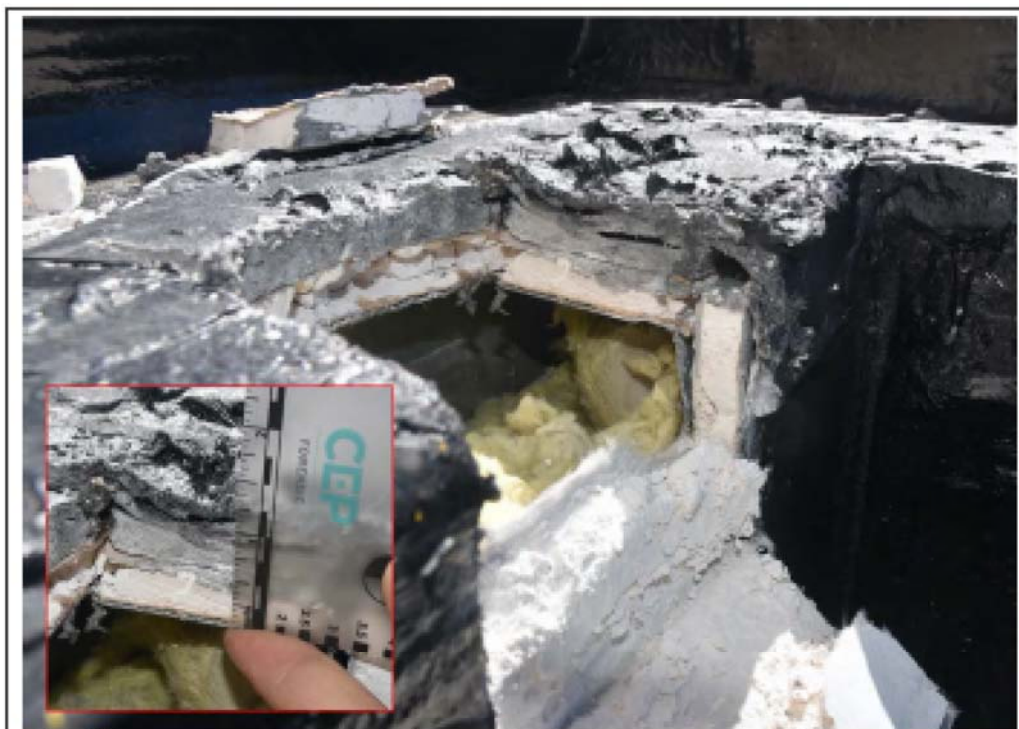
Figure 22 Composition du parapet sous le poteau à l'étude
