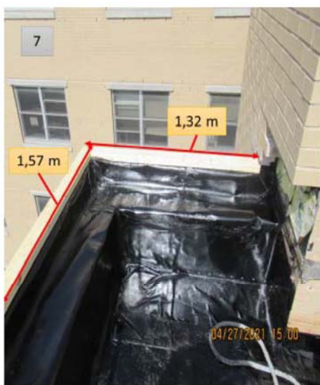
Photos 7 et 8 : Garde-corps manquants, bassin D-6-1
