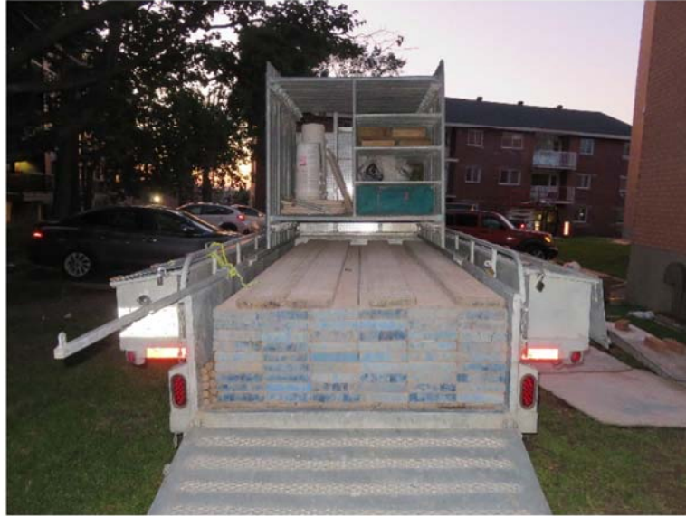
Figure 10 – Madriers lamellés disponibles sur le chantier Source : CNESST
