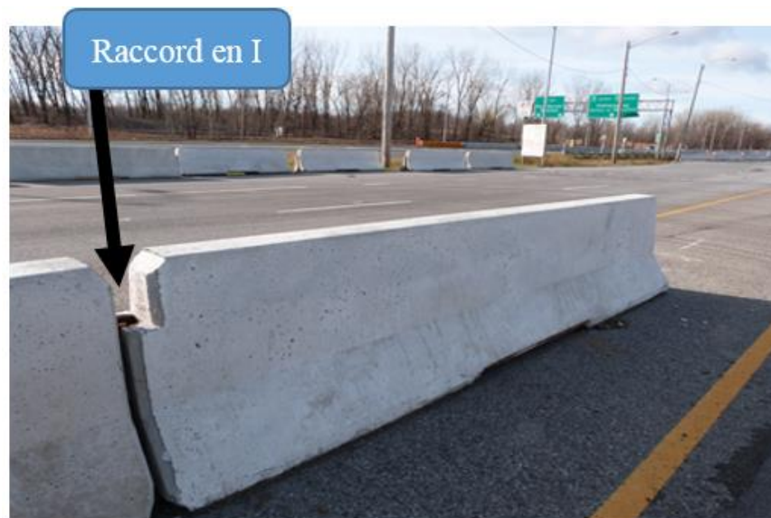
Figure 9 : Glissières en béton pour chantiers avec raccord en I (Source : https://www.signal.ca/product/barriere-en-beton-new-jersey-glissiere-de-securite/ , modifiée par la CNESST)
