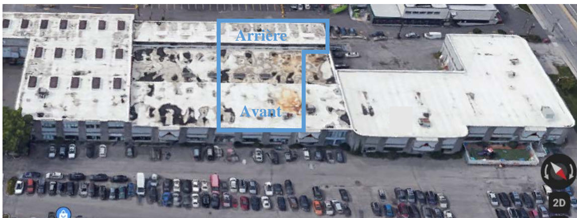
Photo 2 : Bâtiment abritant le local occupé par l'entreprise Tuiles et évier
