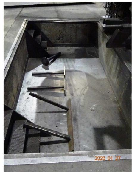
Photos 14 et 15 : Les poteaux placés dans la fosse (ces poteaux étaient debout avant l'accident)
