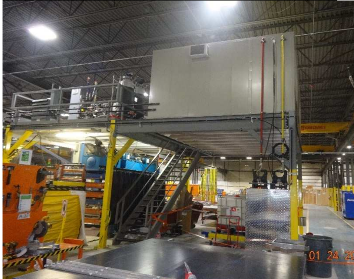
Photo 4 : Extérieur de la chambre des réservoirs
