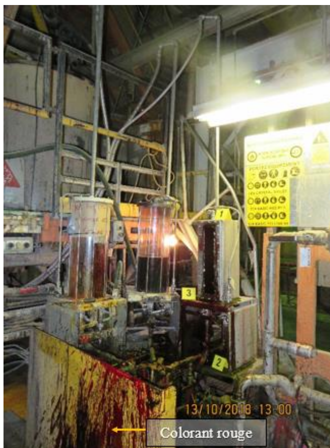
Photo 1 – Poste de coloration - réservoir de mesure de colorant rouge Source : CNESST
