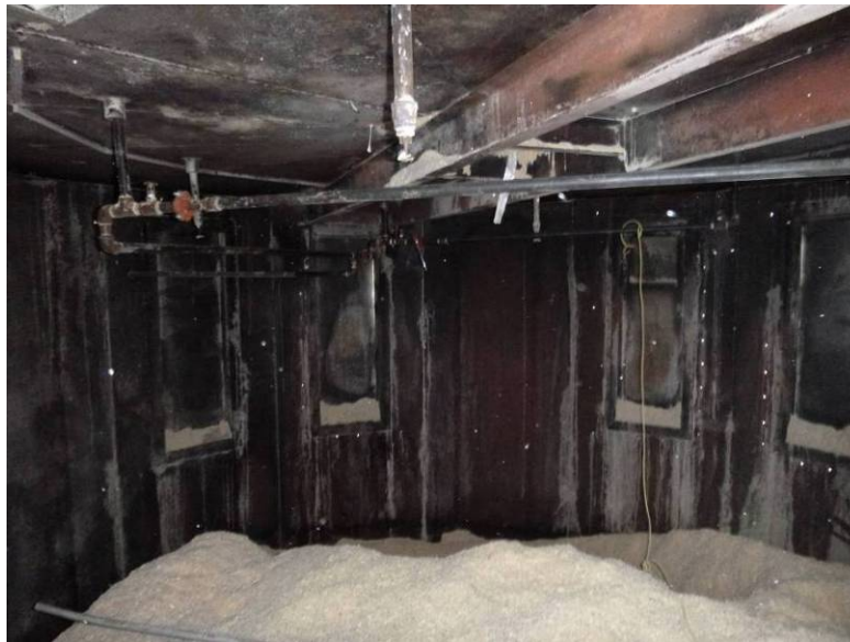
Photo 1 : Intérieur du silo à bran de scie impliqué dans l'accident Source : CSST
