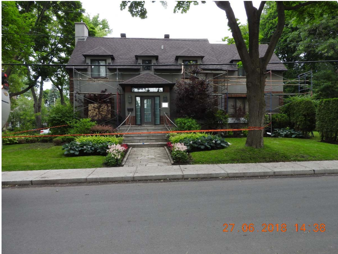
Photo 4 : Échafaudages (source CNESST)
