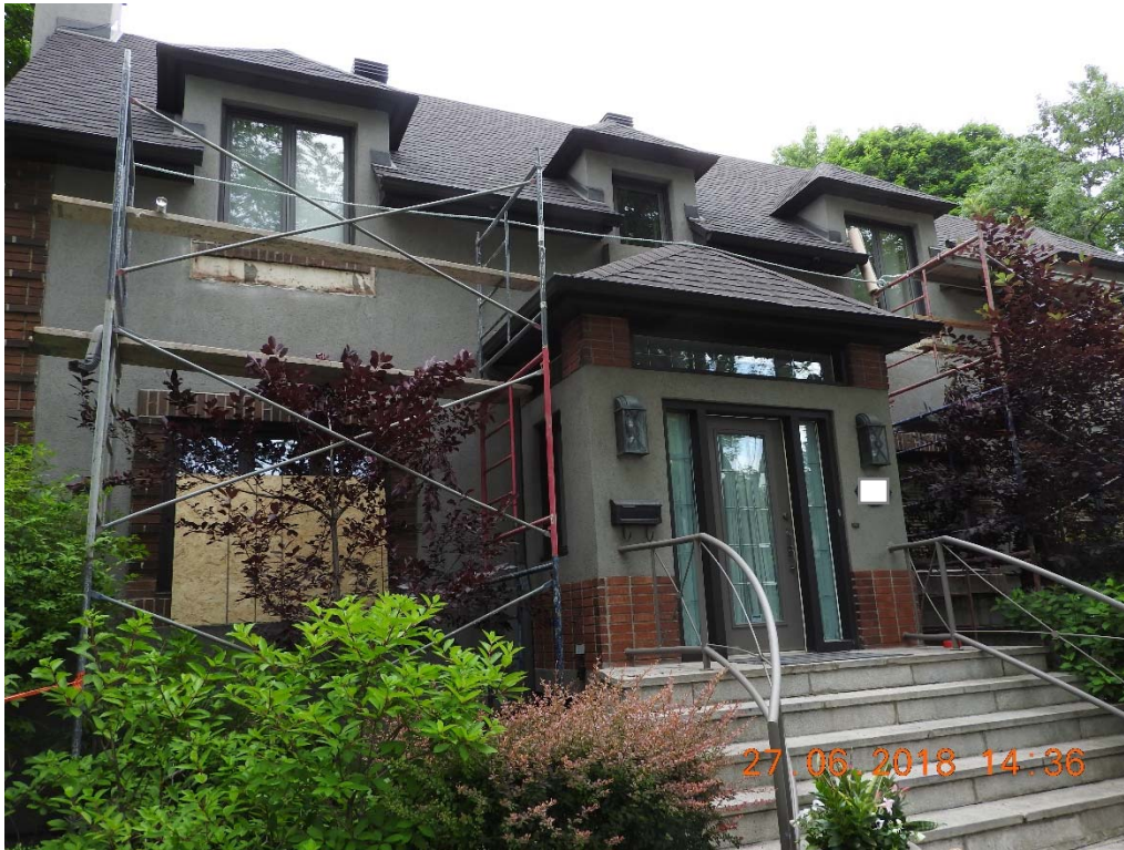
Photo 1 : Lieu de l'accident (source CNESST)
