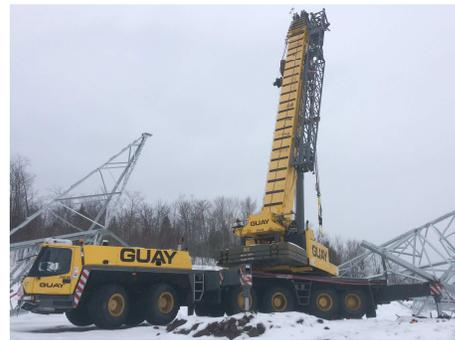
Photo 8 : Grue mobile utilisée pour le levage des structures
