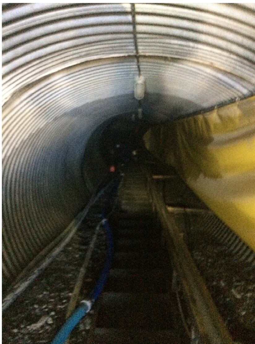
Tunnel d'accès à la galerie souterraine (Photo Sécurité Incendie Murdochville)
