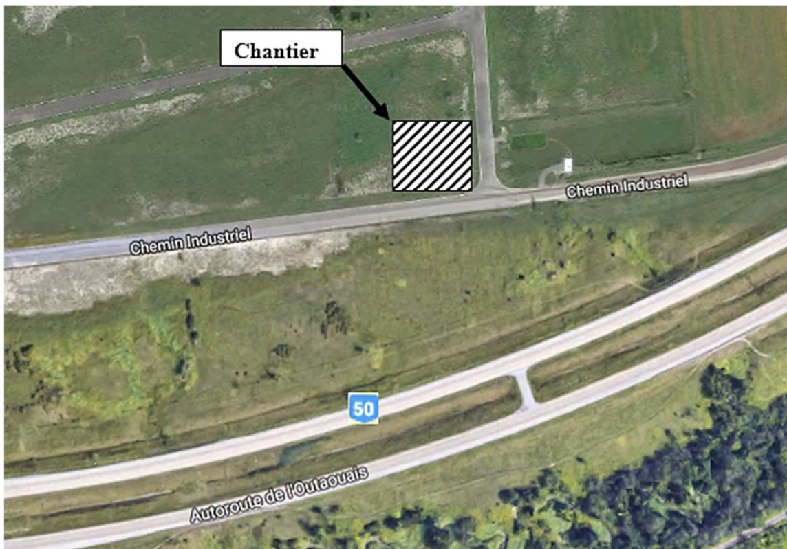
Photo 2 : Vue aérienne du site du chantier (Source : Google maps)
