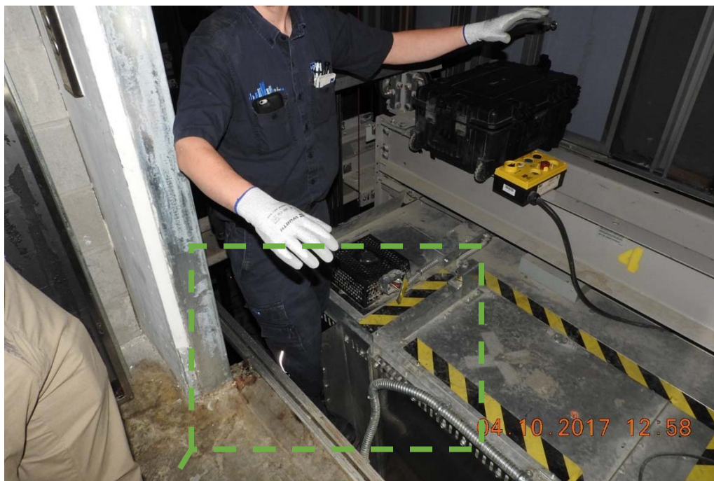
Photo 14 : Zone de coincement Source : CNESST
