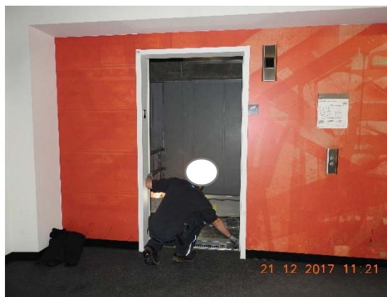
Photos 7 et 8 : Reconstitution : étapes à suivre pour l'accès au toit de la cabine Source : CNESST
