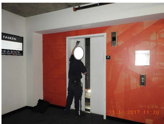
Photos 7 et 8 : Reconstitution : étapes à suivre pour l'accès au toit de la cabine Source : CNESST
