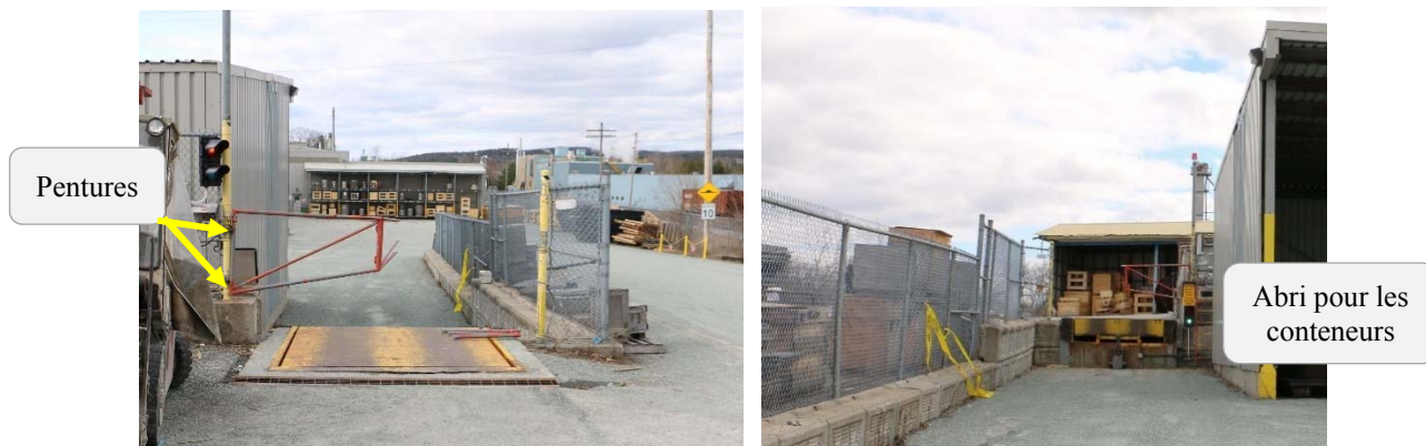
Figure 6 : Quai de chargement
