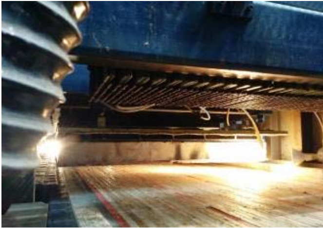
Photo 2: entrée de la colleuse, plateau en haut (serre-joints non-activé).
