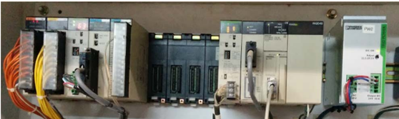
Photo 22: automate programmable OMRON CS1G et ses cartes d'entrées/sorties
