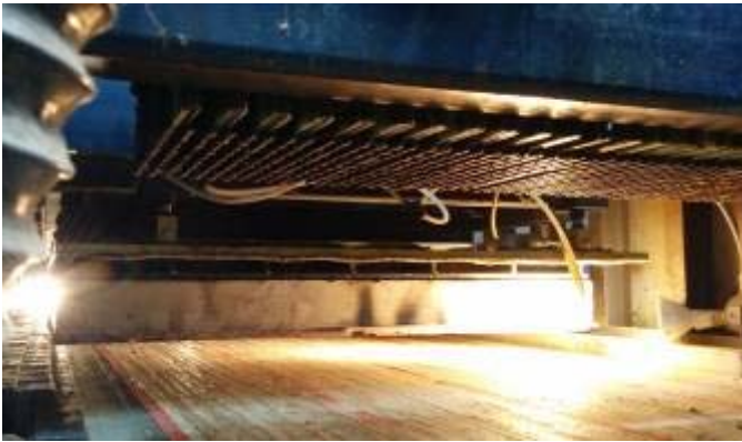
Photo 33: serres-joints en position haute (électrovanne du distributeur pneumatique des cylindres du serre-joints activé)
