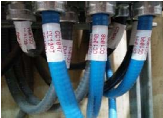
Photo 29 : câbles de type « TECK » utilisés pour le réseau « DeviceNet »
