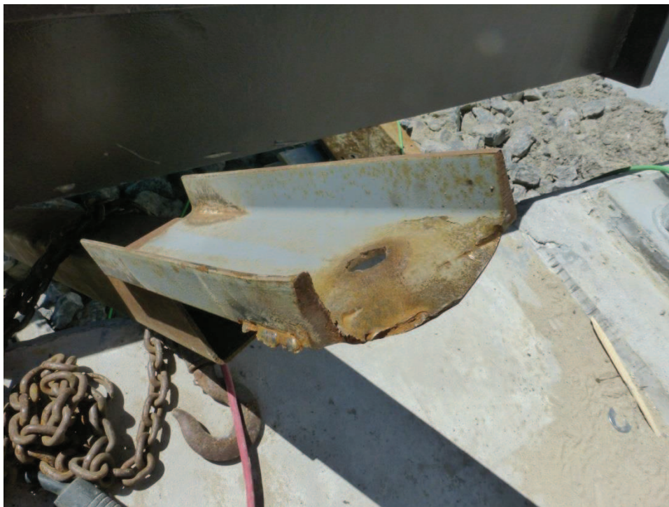
Figure 55 – Extrémité soudée de la diagonale de contreventement
