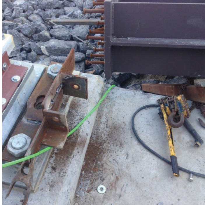
Figure 53 – Système temporaire d'attache du support de verticalité au système d'appui adjacent à l'extrémité est de la poutre P4
