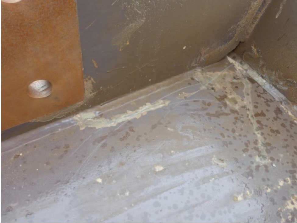
Figure 43 – Traces de l'impact du support de verticalité et de l'empreinte du boulon, apparentes dans la portion supérieure de la poutre
