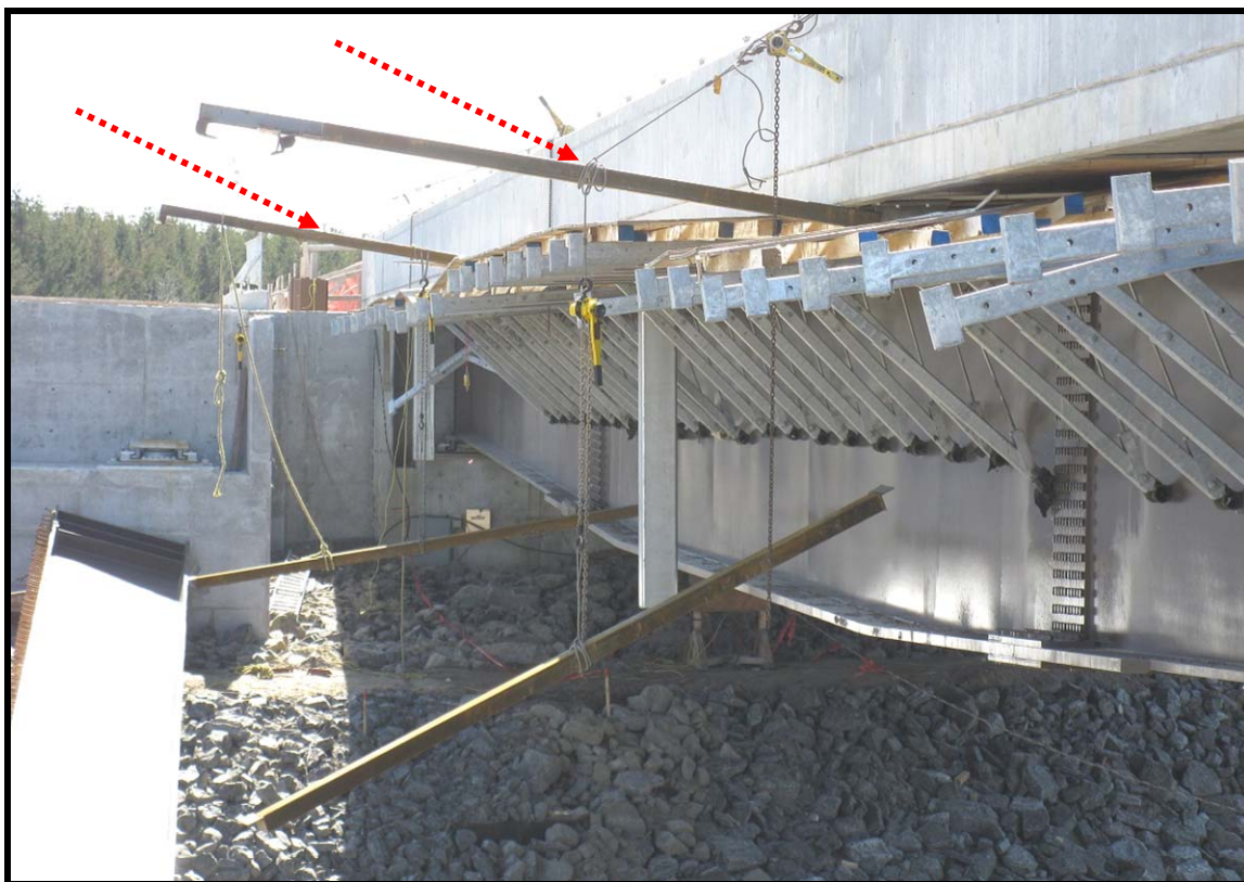
Photo 8 : Position des câbles qui soutiennent les supports latéraux temporaires. Source : CNESST (3948)
