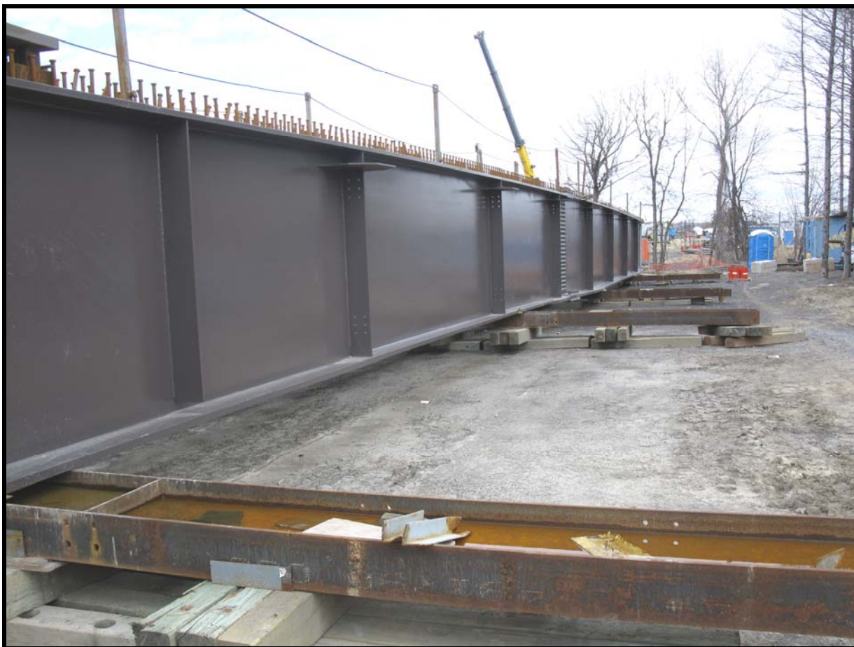
Photo 2 : Deux sections de la poutre P3 assemblées par boulonnage sur la berge ouest. Source : CNESST (4318)
