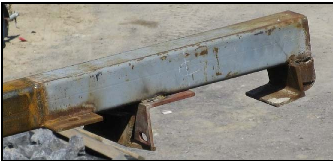
Photo 10 : Poutre et main du support latéral temporaire, côté est.
