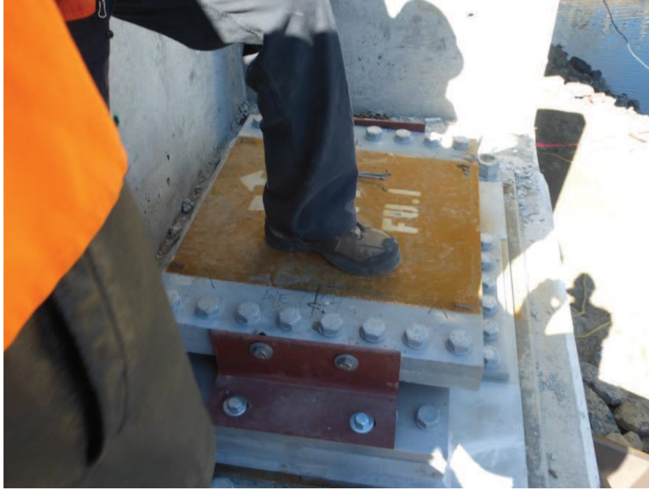
Figure 47 – Quatre cordons de soudure visibles sur la plaque d’assise de l’appareil d’appui ouest
