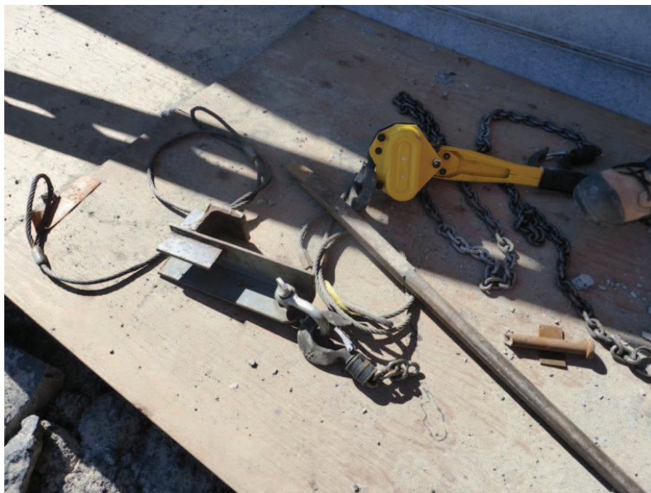
Figure 45 – Figure montrant quelques éléments et outils de construction trouvés à l'extrémité ouest de la poutre
