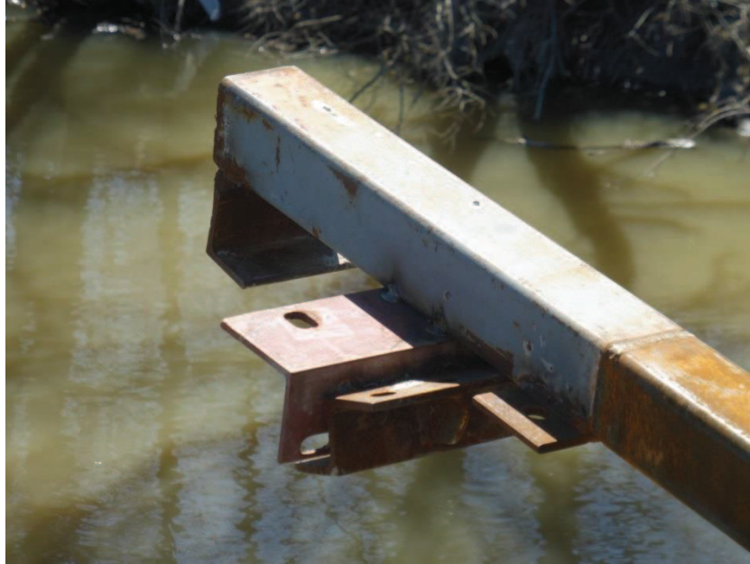
Figure 30 - Extrémité sud du SLT situé du côté est (Québec)
