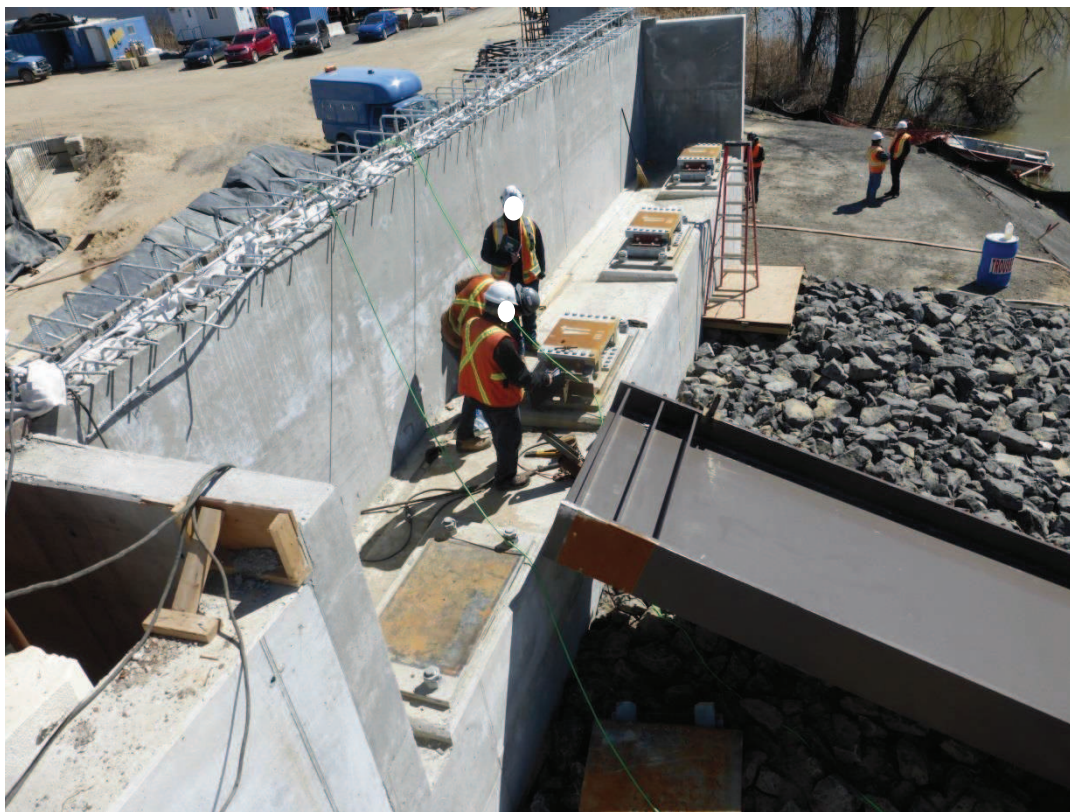
Figure 60 – Position finale de la poutre sur le sol après le déversement
