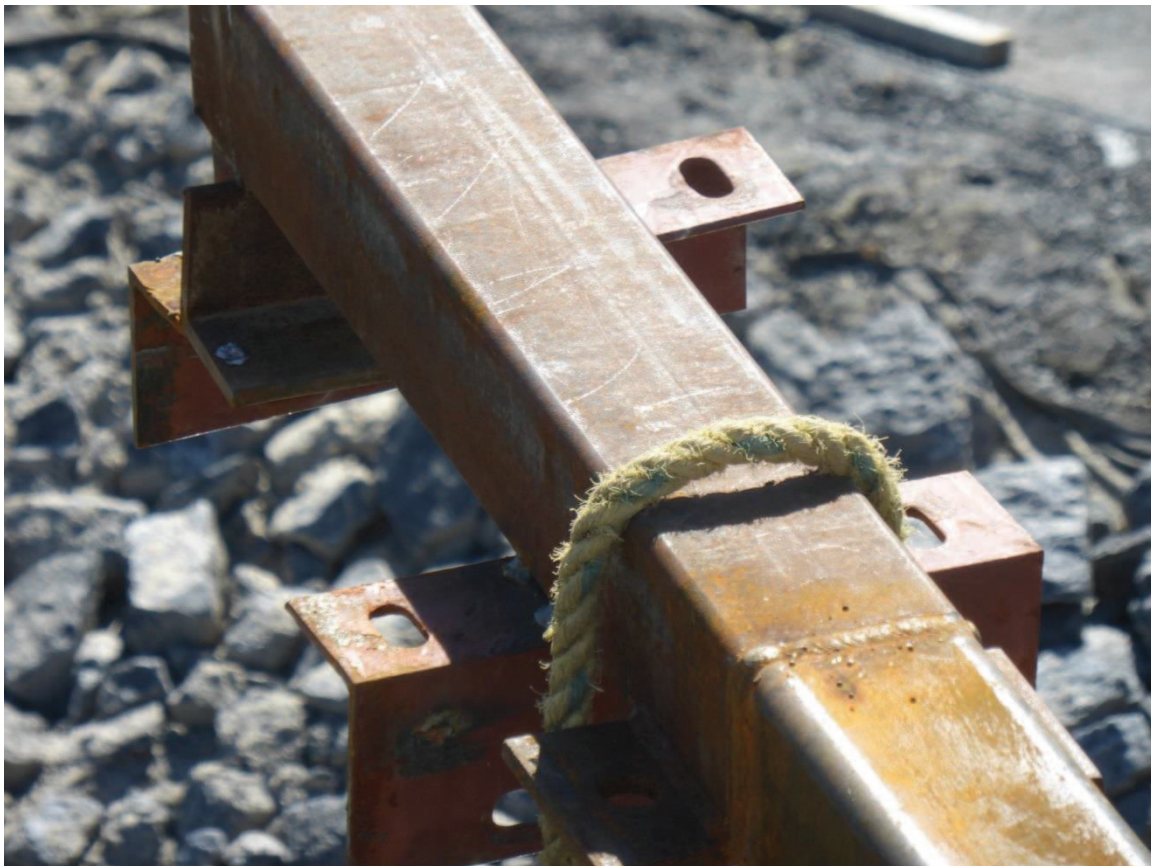
Figure 27 – Extrémité sud du SLT situé du côté ouest (Montréal)
