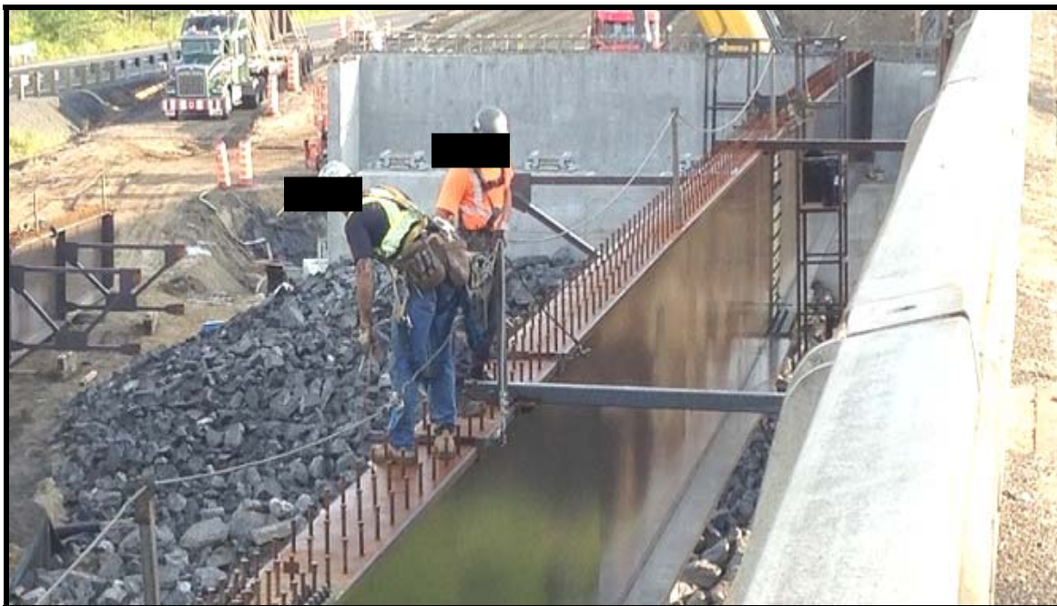
Photo 15 : Supports latéraux temporaires installés sur la 1 re poutre du pont nord en 2015 Source : WSP / EXP
