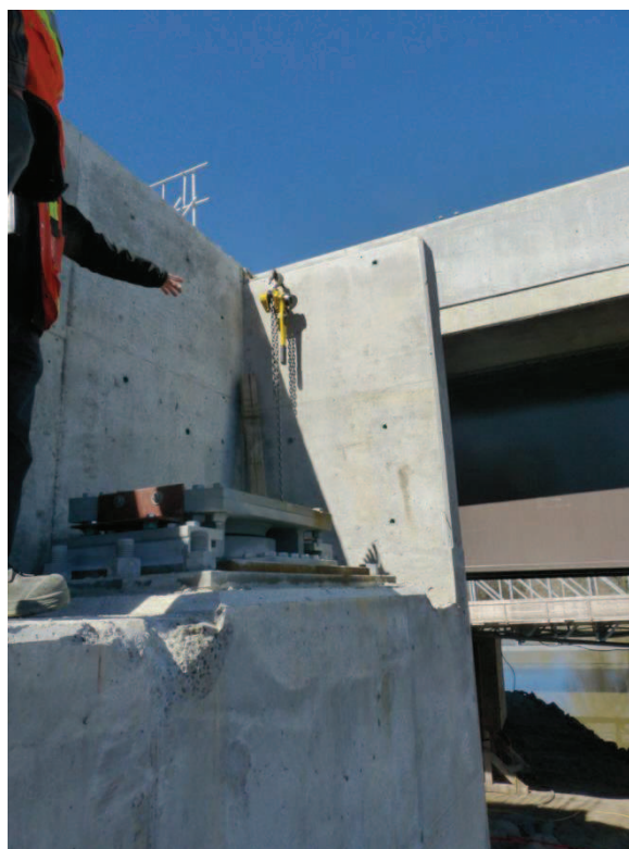
Figure 46 – Palan à crochet utilisé pour stabiliser la poutre à son extrémité ouest
