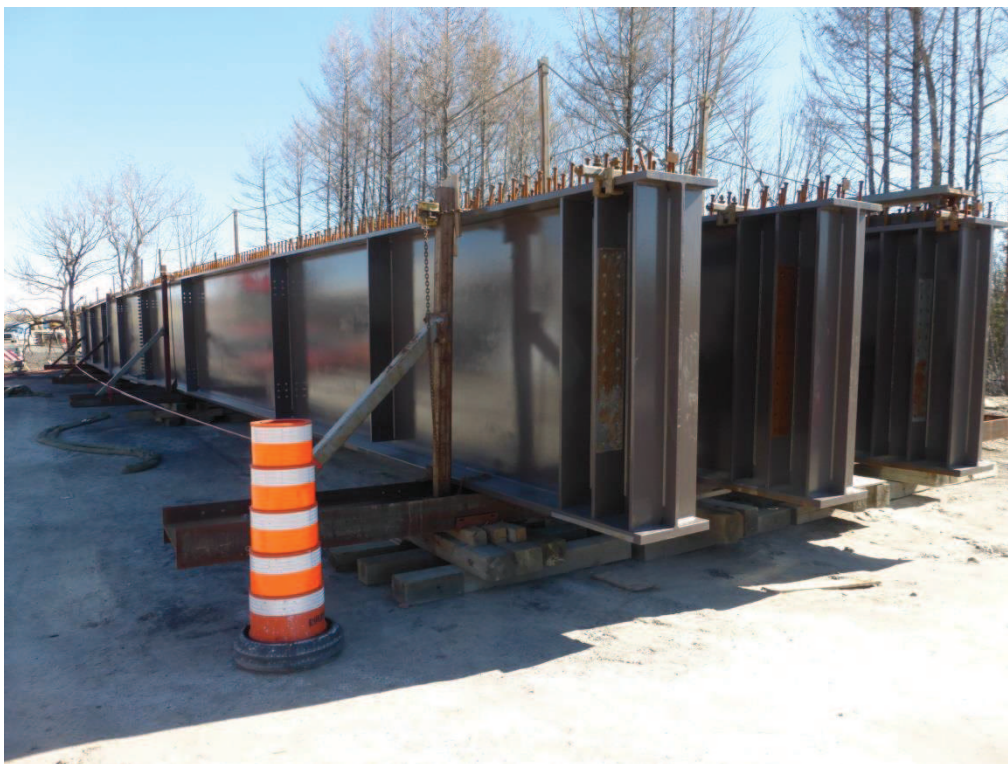
Figure 2 – Assemblage des segments de poutre sur le banc de montage du côté de Montréal
