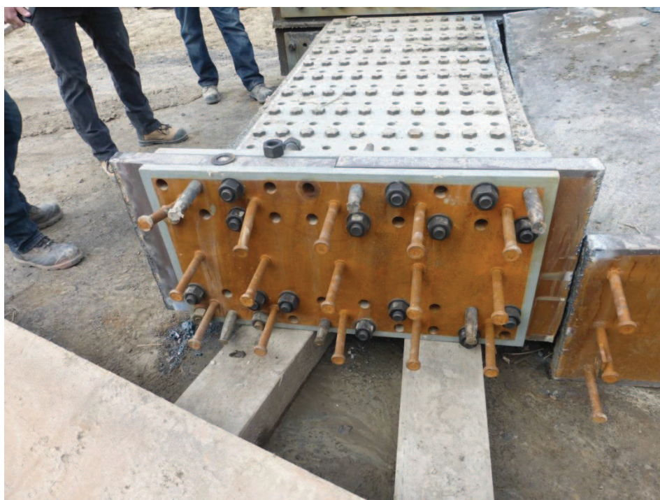
Figure 14– Vue de l’aile en compression montrant six chevilles
