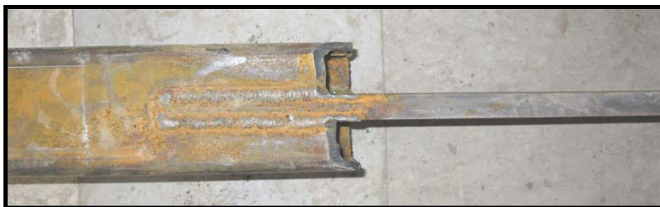
Photo 7 : Coupe en biseau facilitant le soulèvement du support latéral temporaire du côté est. Source : CNESST (4366)
