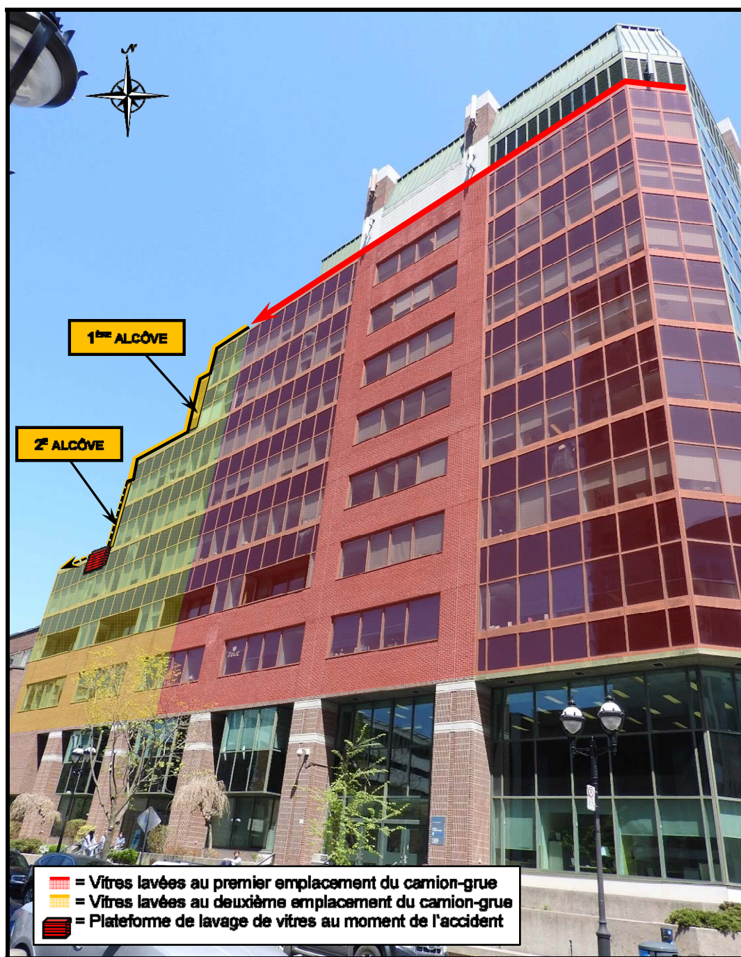
Photo n° 3 : Représentations de la séquence de lavage des vitres de la façade de l'édifice située sur la rue Saint-Denis et de la position de la plateforme au moment de l'accident (Source : CNESST)
