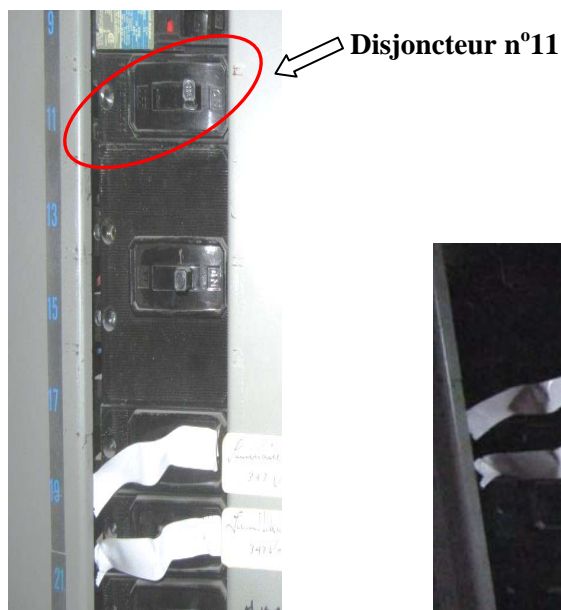
Photo 4 : Identification des disjoncteurs du panneau électrique (Source : CNESST)
