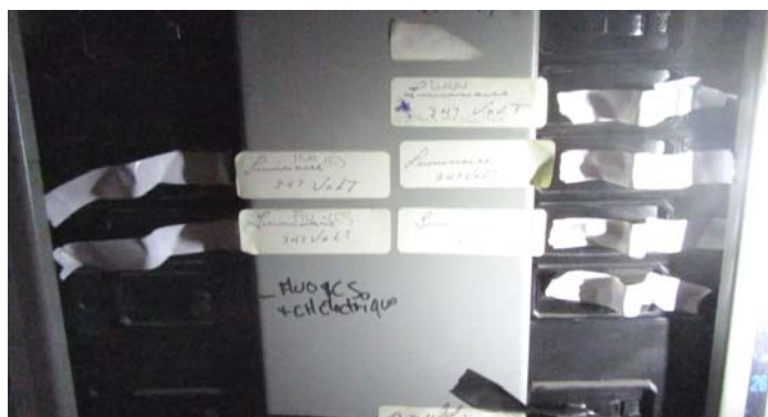
Photo 4 : Identification des disjoncteurs du panneau électrique (Source : CNESST)
