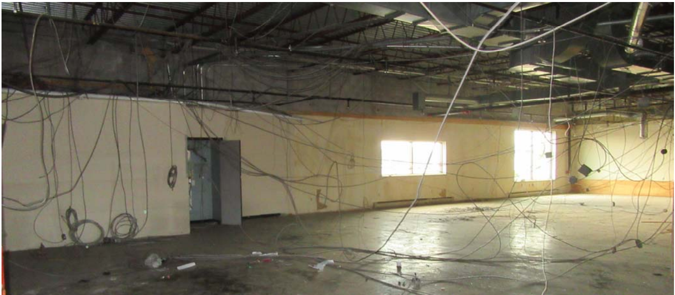
Photo 1 : Lieu de l'accident (Source : CNESST)
