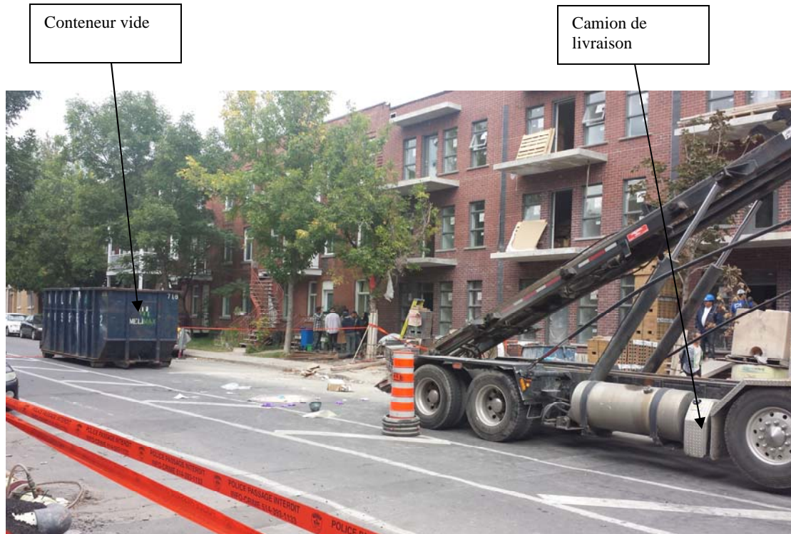
Photo 4 : Zone des opérations de livraison sur la voie de circulation (source : CNESST)
